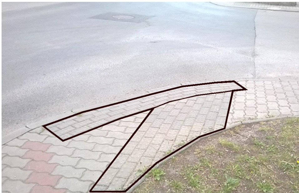
Obrázek 9 – Detail nesymetrického varovného pásu
