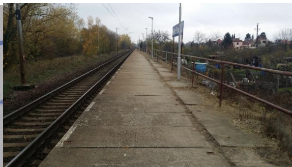
Obrázek 26. – Pohled na nástupiště v zastávce Hradec Králové zastávka
