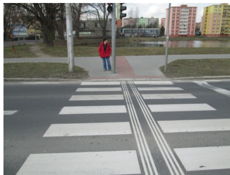
Obrázek 20: Nesprávné umístění sloupu SSZ
