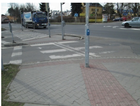
Obrázek 18: Nesprávné provedení signálního pásu 1
