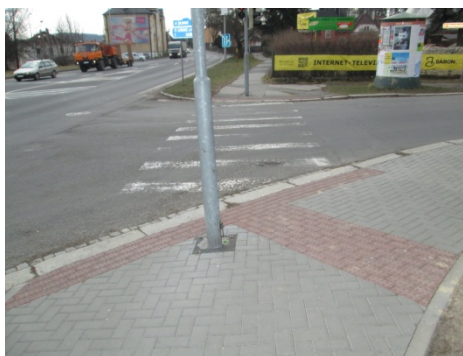
Obrázek 21: Nesprávné provedení signálního pásu a nesprávné umístění sloupu SZZ
