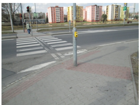
Obrázek 19: Nesprávné provedení signálního pásu 2
