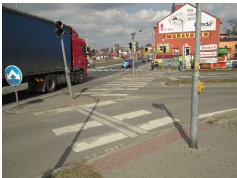
Obrázek 17: Chybějící signální pás
