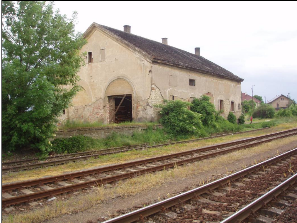
boční rampa u manipulační koleje
