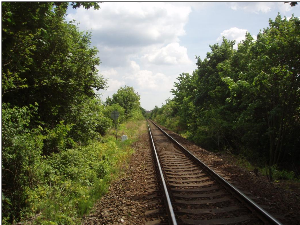
prostory nové zastávky Kladno-sever
