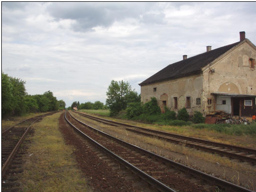
staniční koleje ve směru do Otovic
