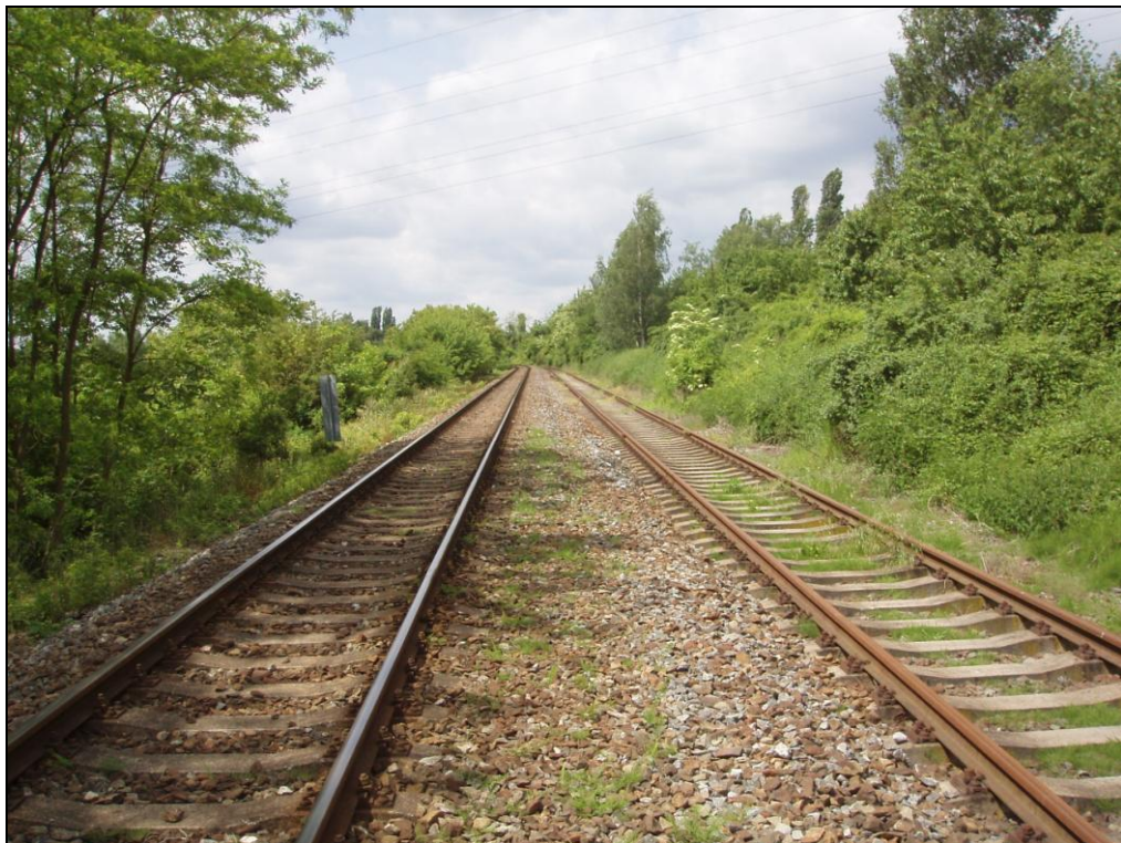
souběh traťové a vlečkové koleje
