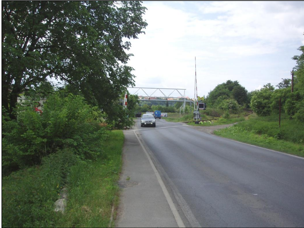
rušený železniční přejezd P2448
