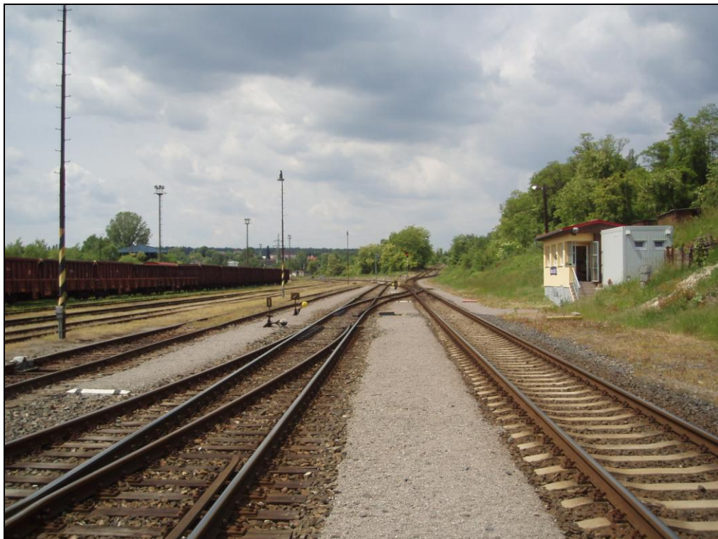
dopravní koleje v prostoru St.II
