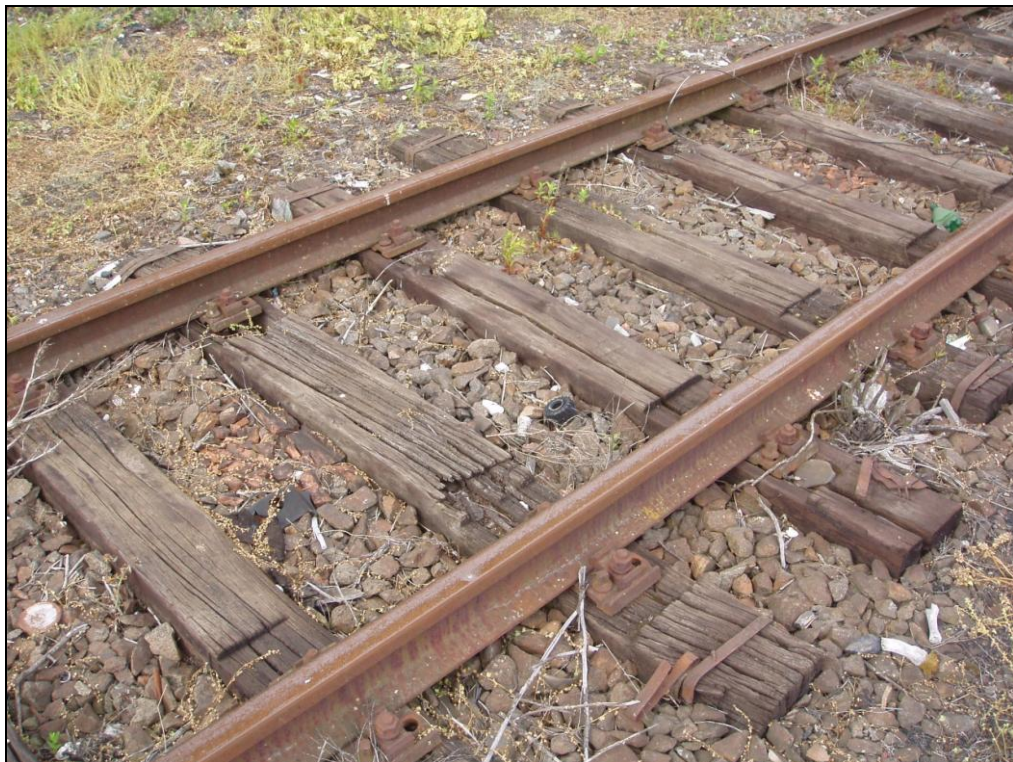
dosluhující kolejový rošt v manipulační koleji
