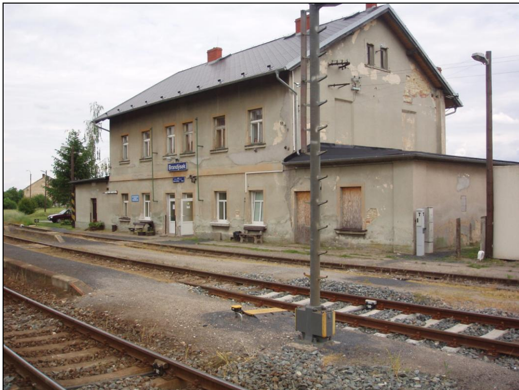
pohled na výpravní budovu
