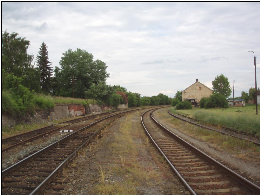
staniční koleje za nástupišti
