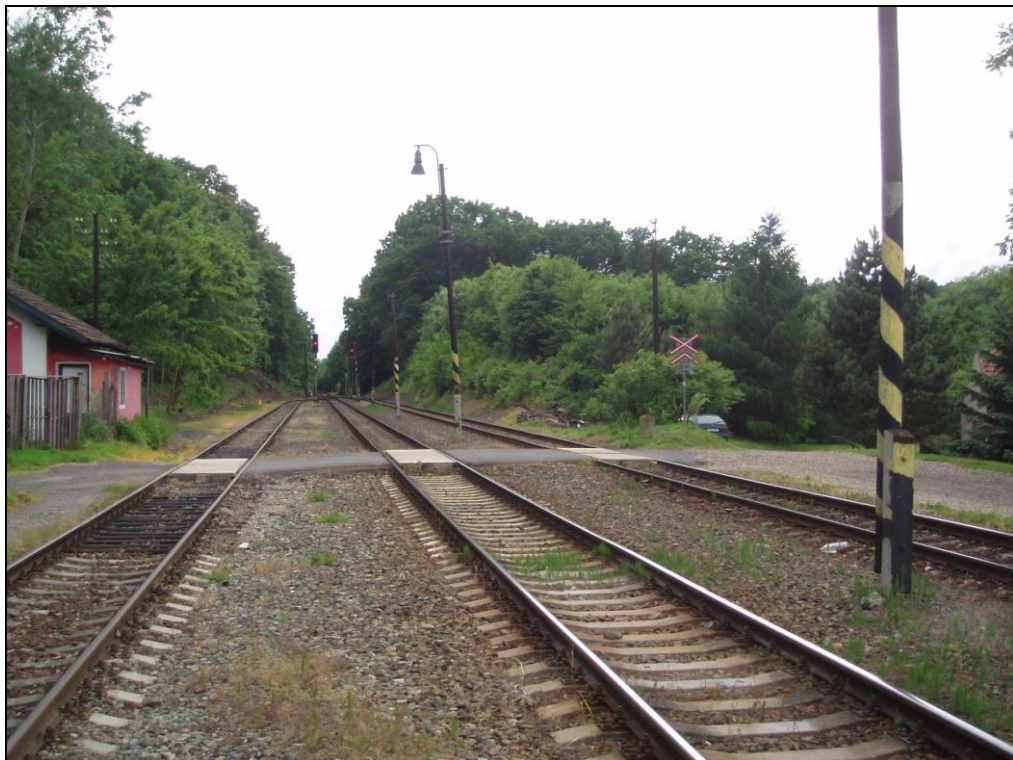
železniční přejezd P2463
