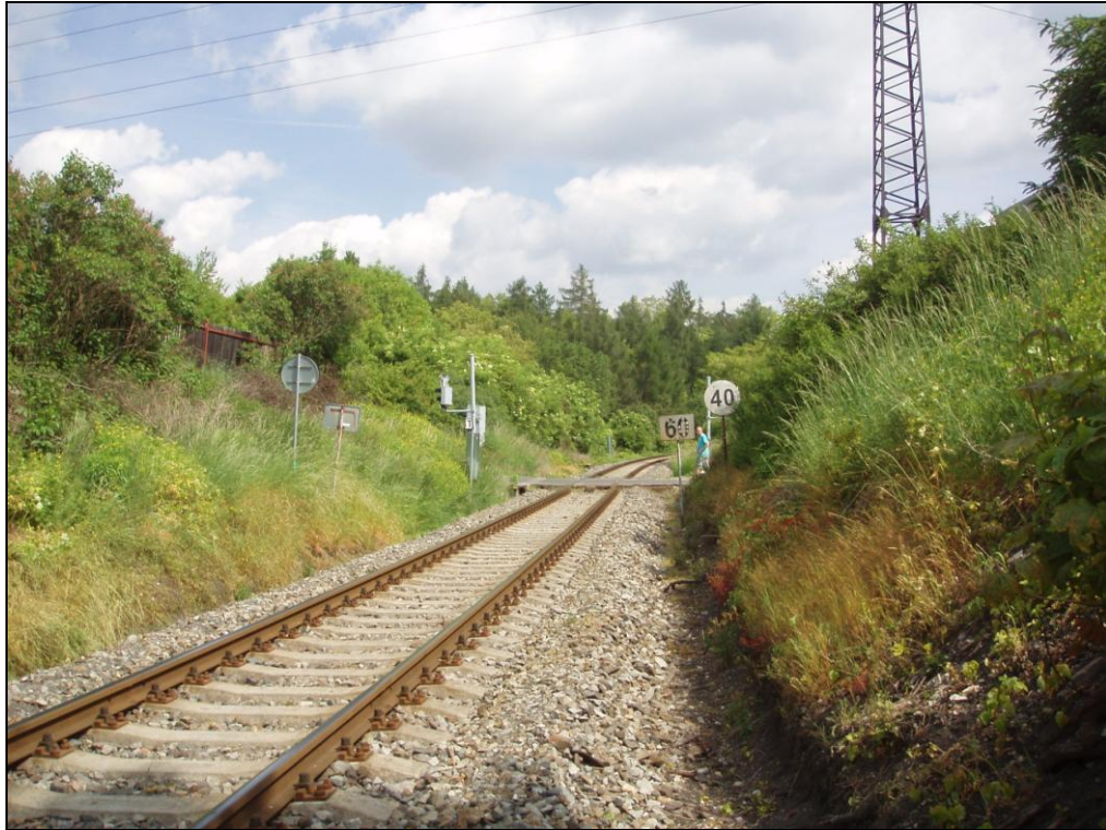
pohled na přejezd P2447
