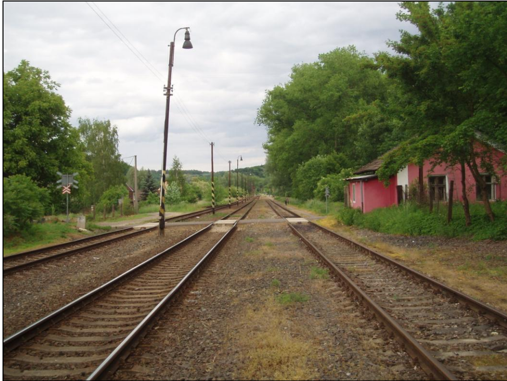
pohled na přejezd P2463
