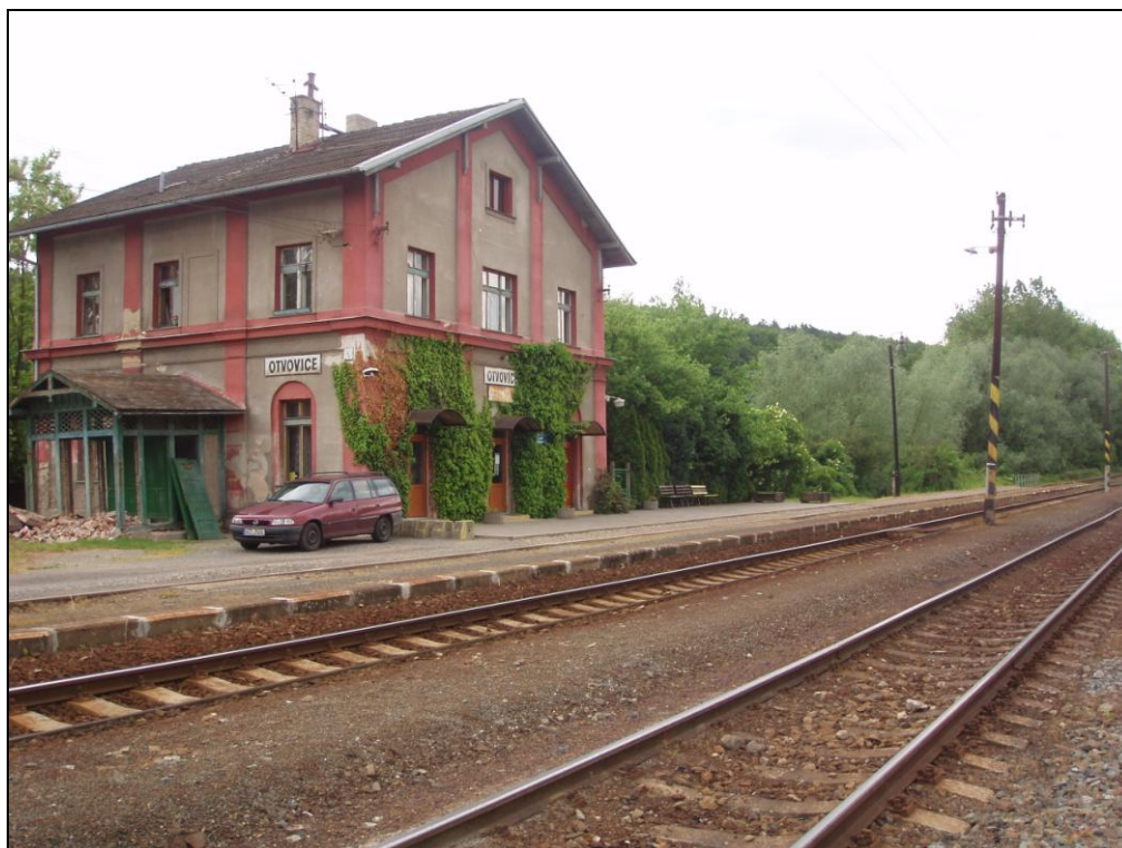
výpravní budova a úrovňová nástupiště
