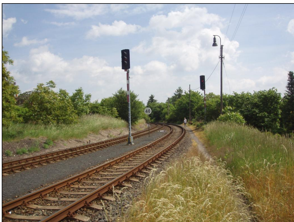
zhlaví stanice Kladno-Ostrovec
