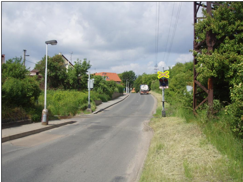
železniční přejezd P2447
