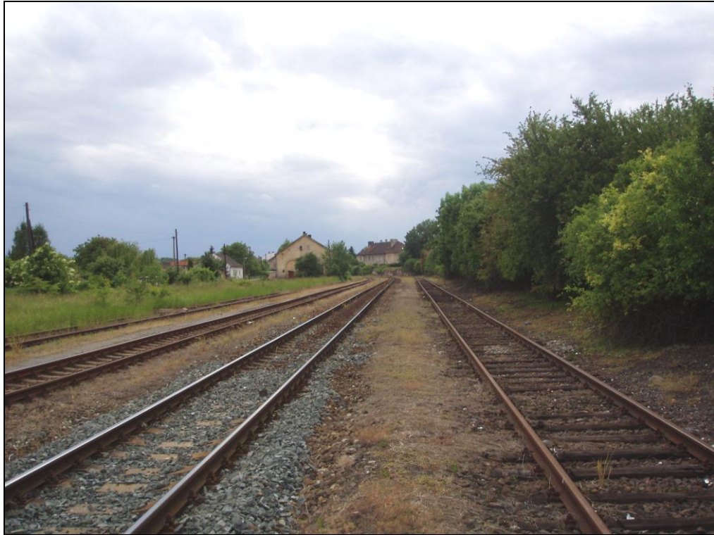
staniční koleje v přímé
