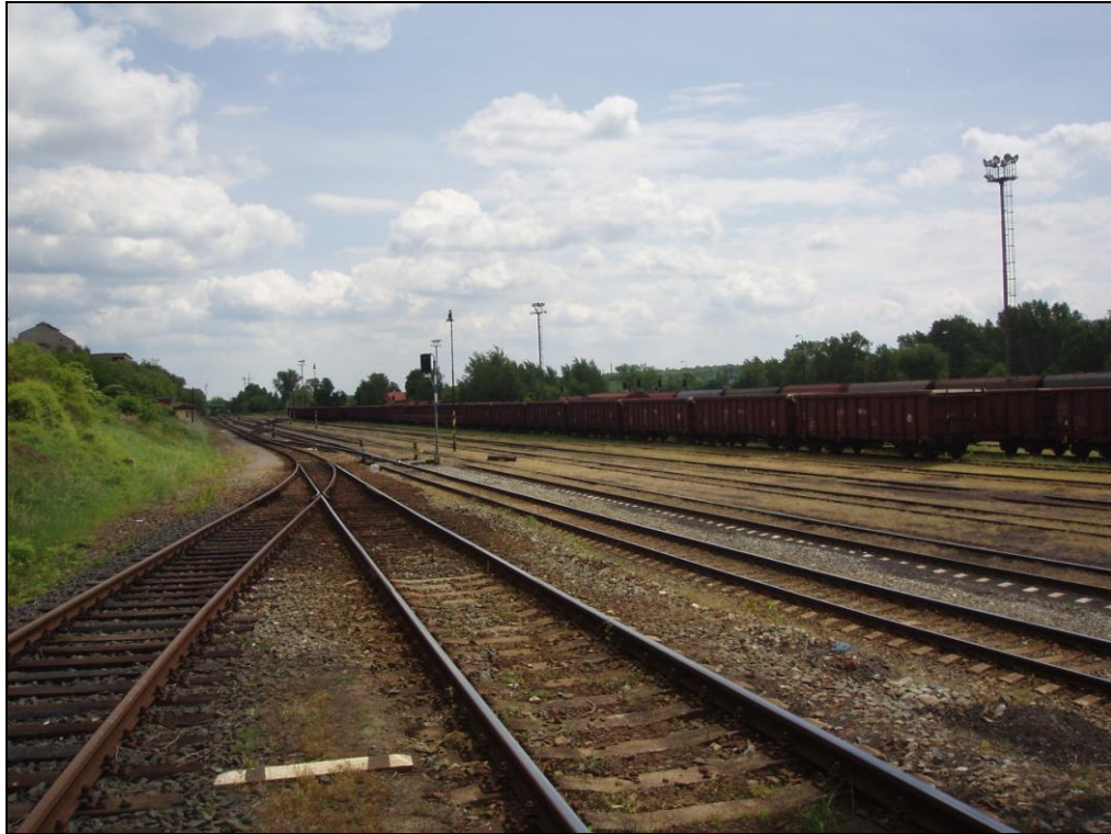
pohled na západní část stanice
