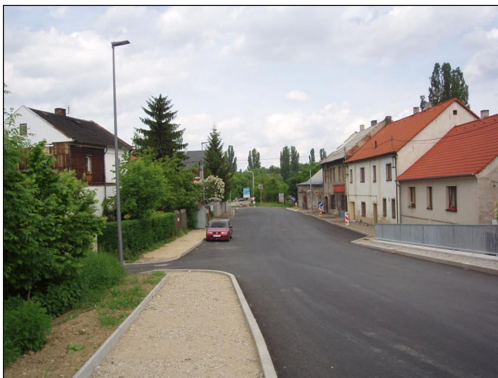
prostory autobusové zastávky Kladno-Švermov
