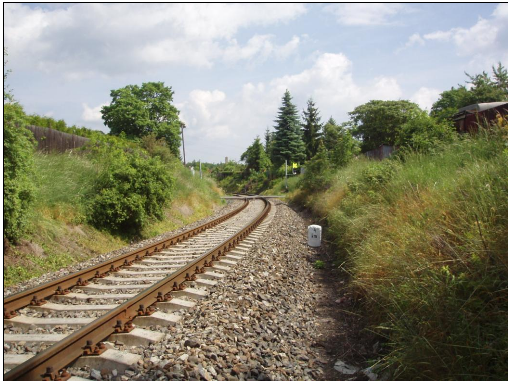
pohled na přejezd P2446
