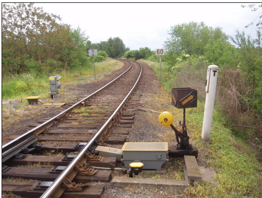
traťový úsek za krajní výhybkou
