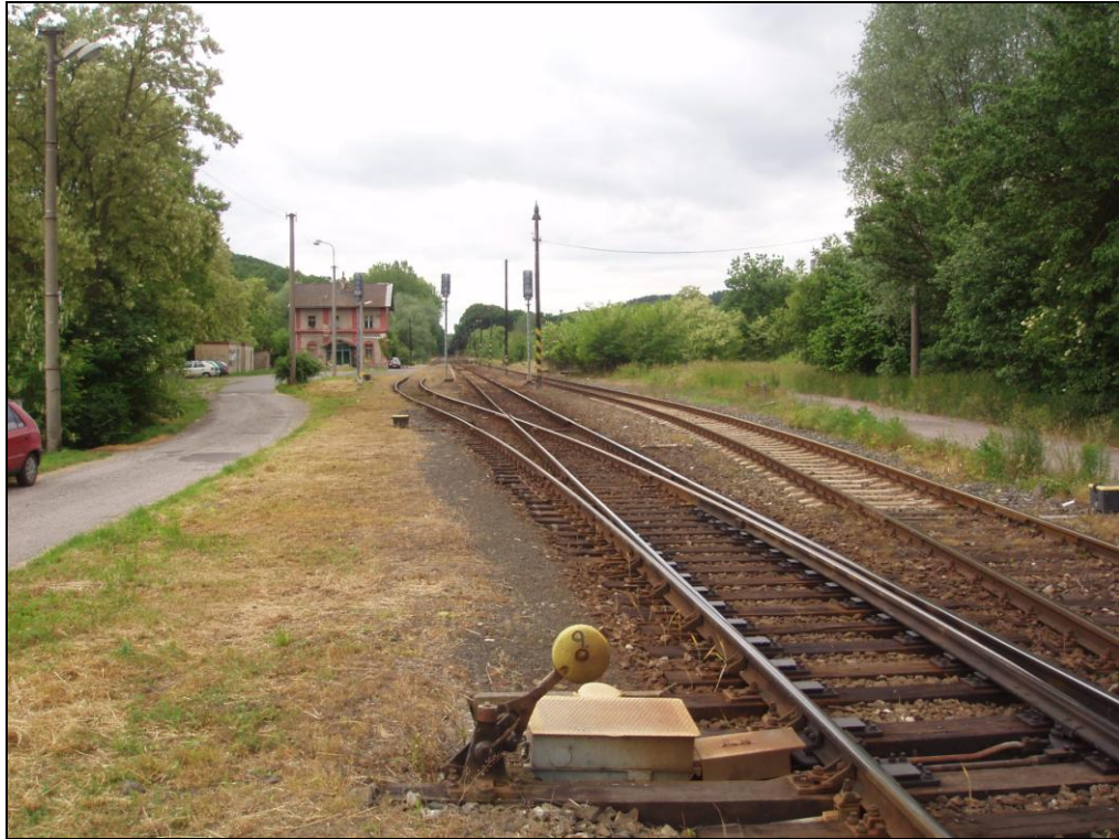
pohled na „kralupské“ zhlaví a příjezdovou komunikaci
