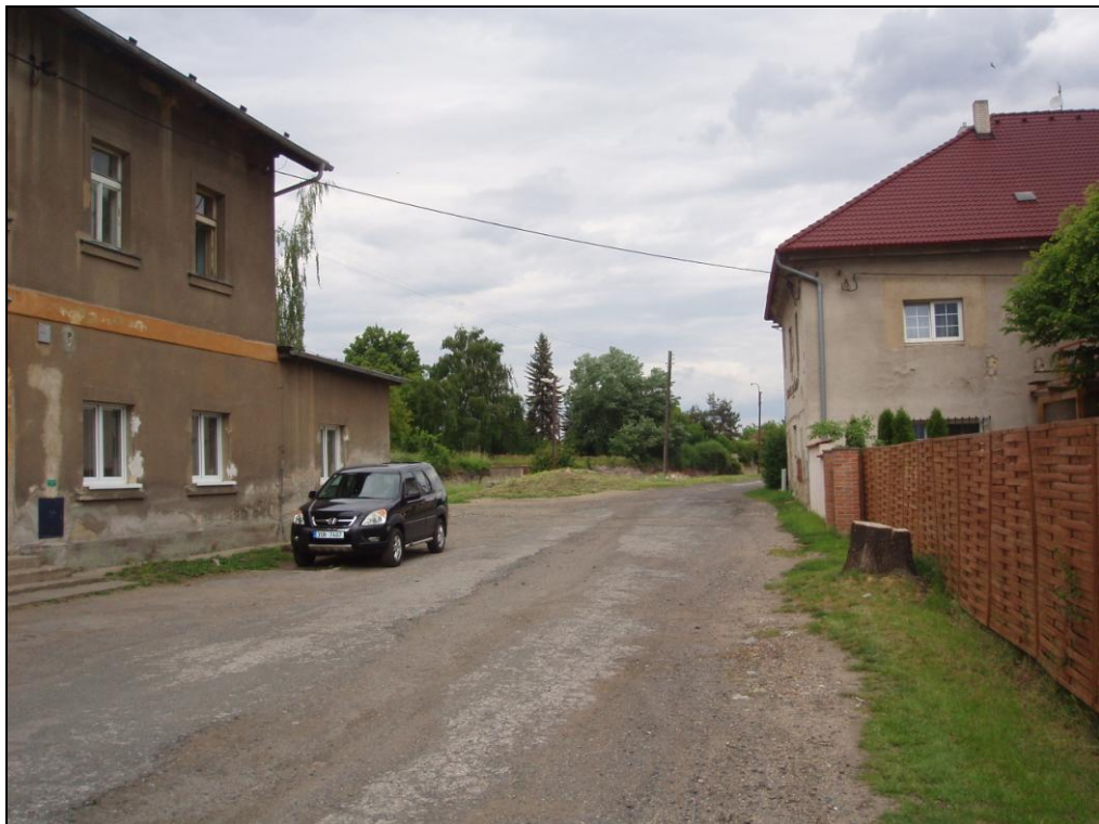
příjezdová komunikace k záchytnému parkovišti
