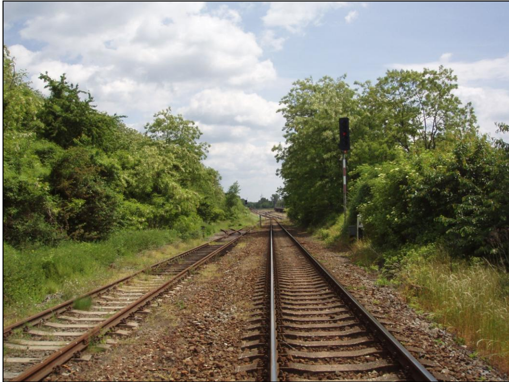
vjezd do stanice
