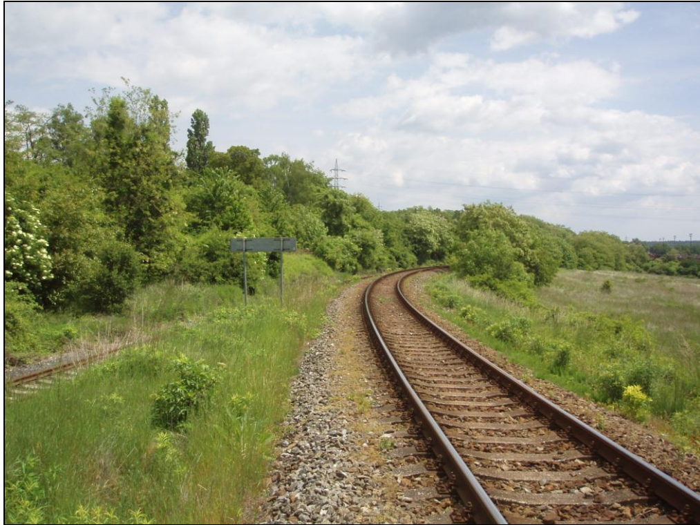
směrový oblouk za zastávkou Kladno-Švermov
