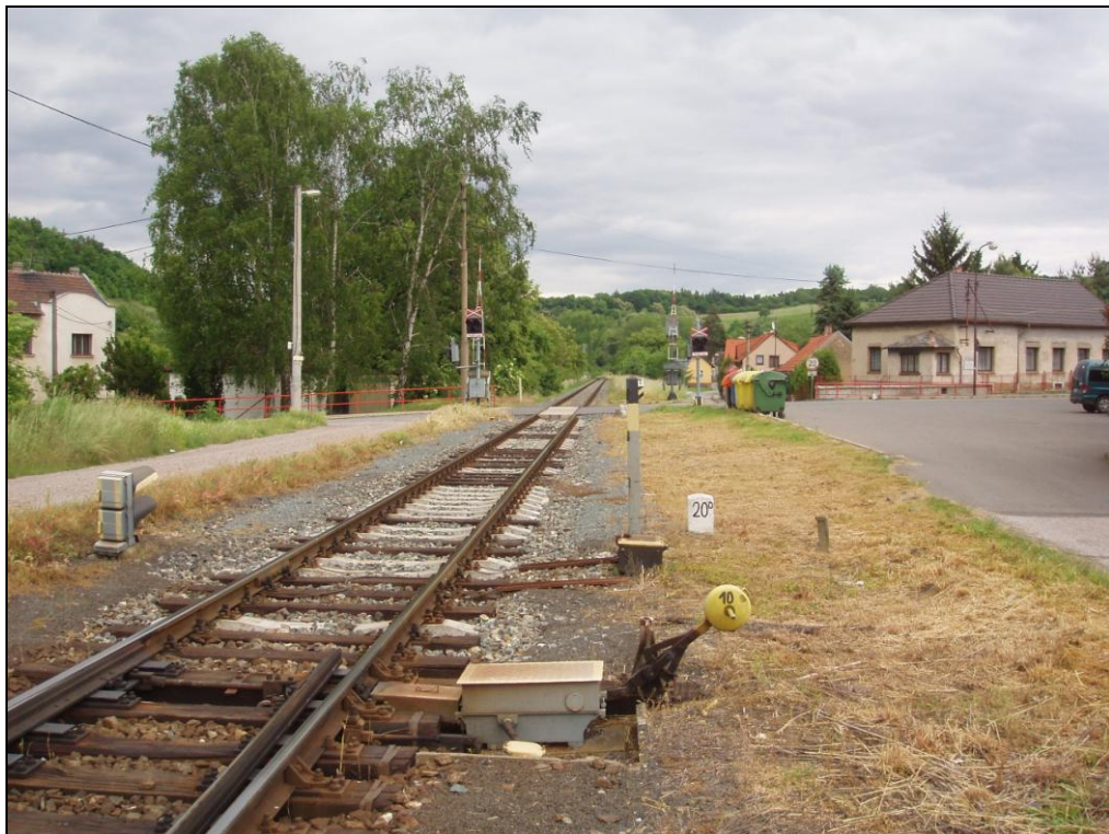
pohled na přejezd P2464
