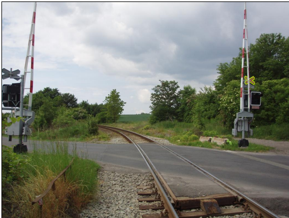
přejezdová konstrukce přejezdu P2448
