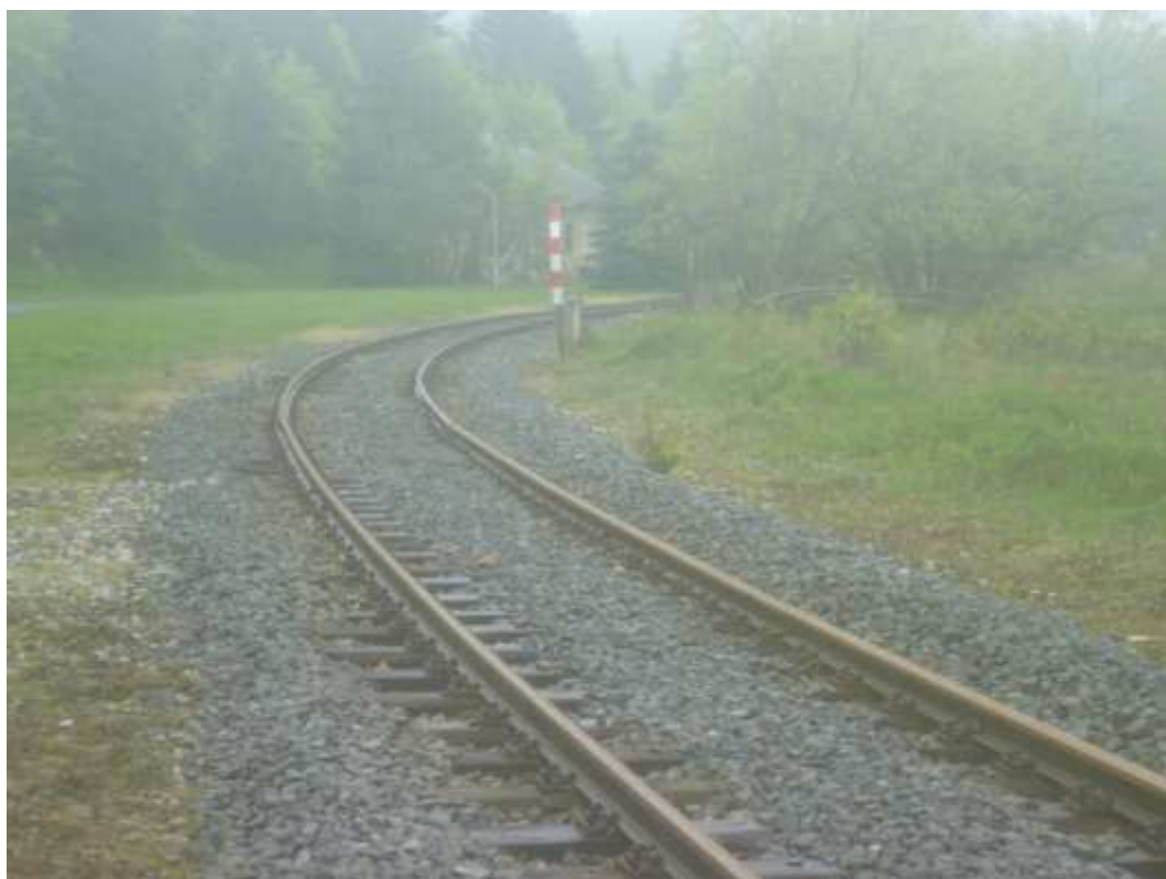
Foto 26: U oblouku vymezeném staničními body km 155,036 a km 155,129 by důsledkem úprav pro zvýšení rychlosti došlo ke zvětšení vrcholového odsazení o 212 mm; pohled ve směru staničení
