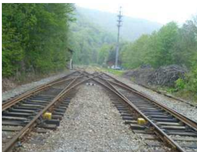
Foto 17: Mostecko-moldavské zhlaví železniční stanice Dubí; pohled ve směru staničení
