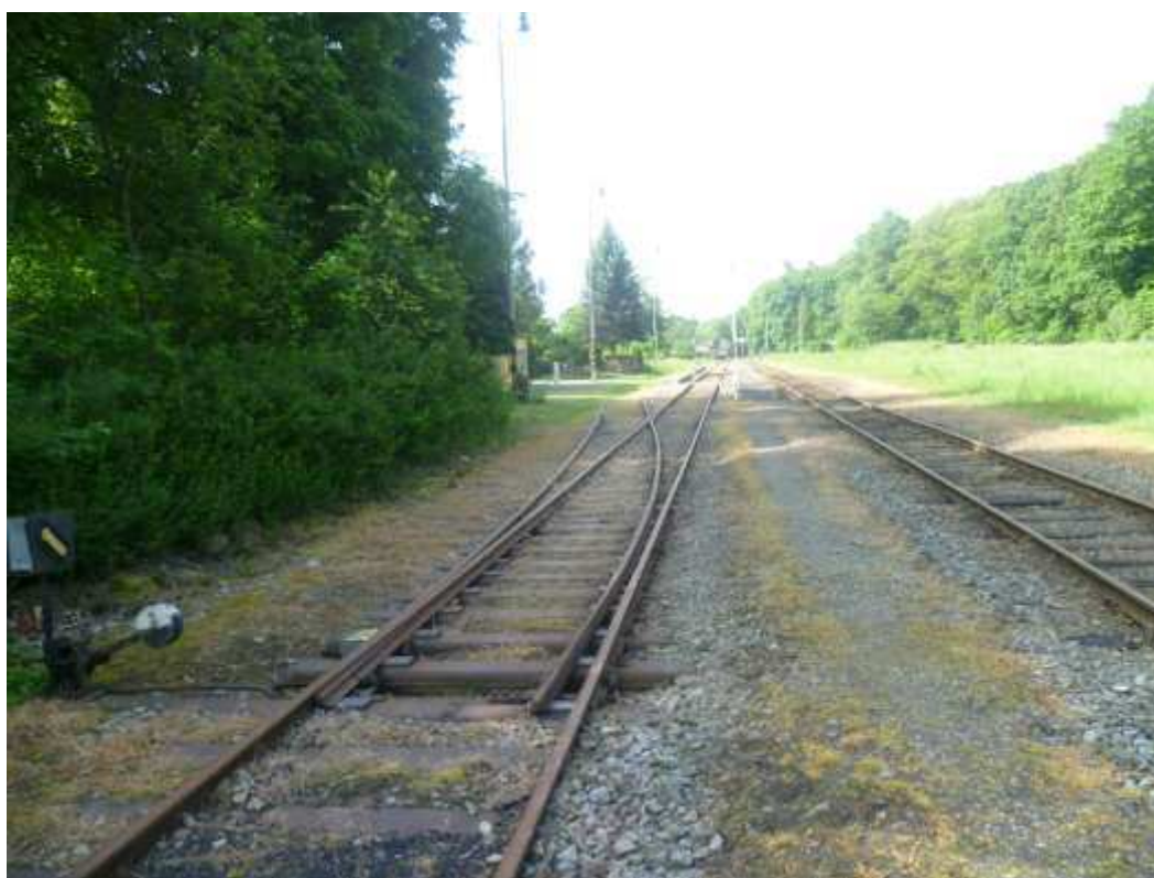
Foto 5: Část moldavského zhlaví železniční stanice Osek město; pohled proti směru staničení
