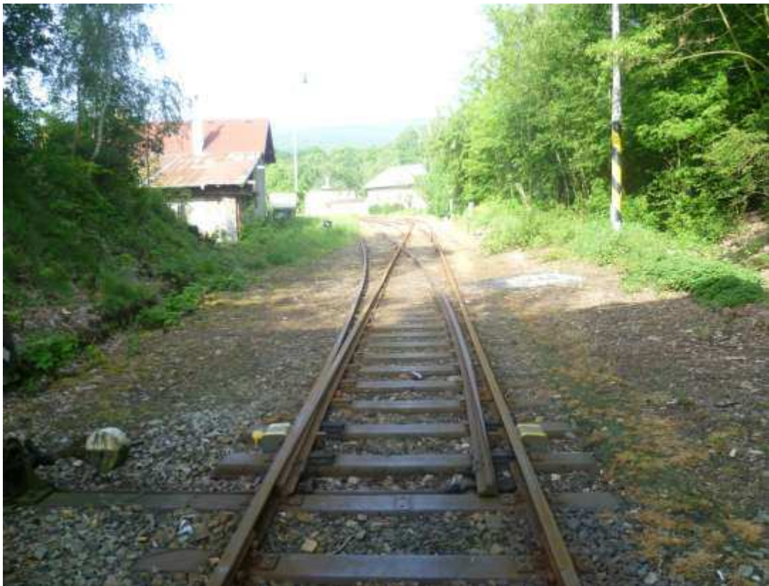
Foto 13: Část moldavského zhlaví železniční stanice Hrob je v oblouku; pohled proti směru staničení
