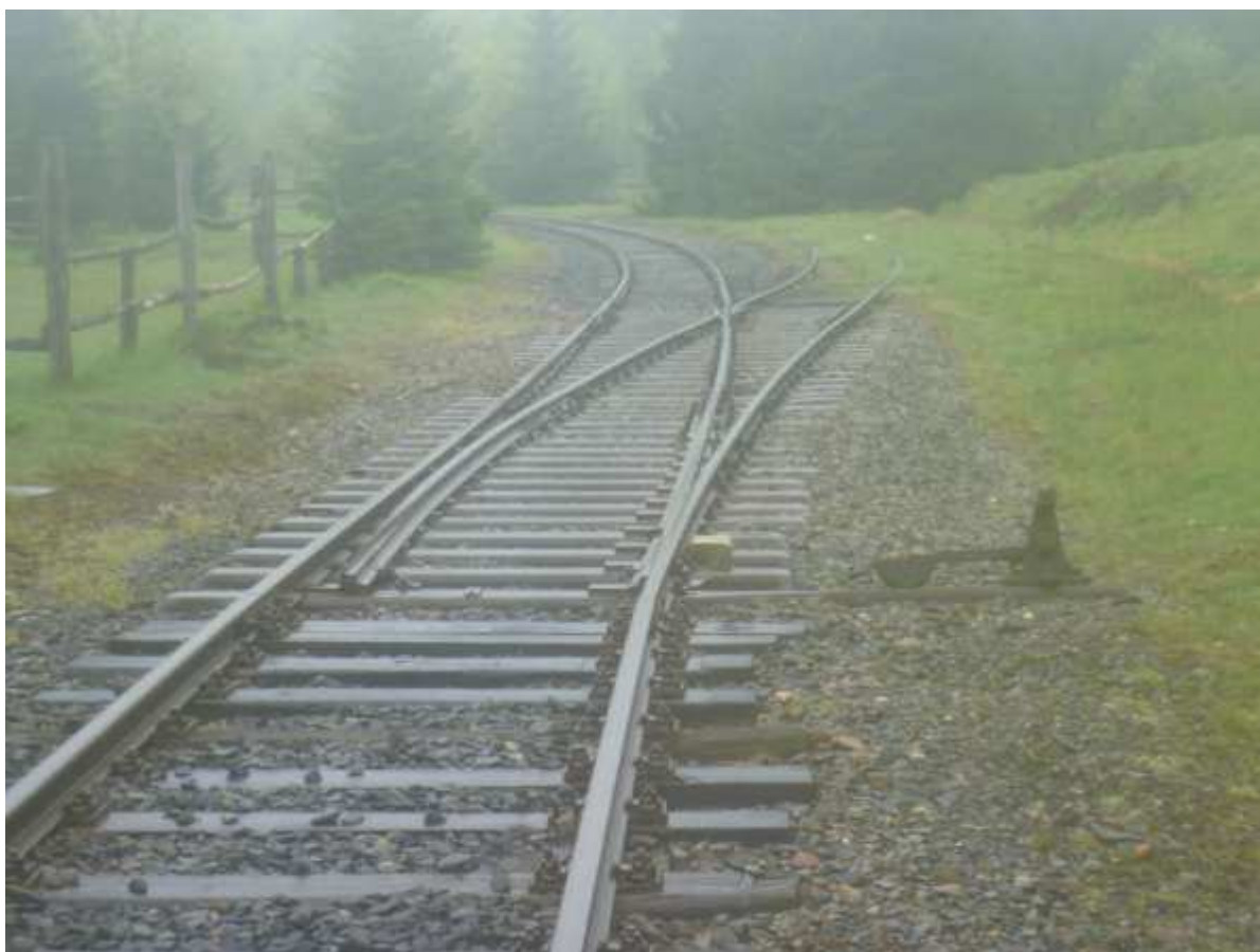
Foto 37: Výhybková konstrukce v km 155,565 – pozůstatek z doby, kdy Mikulov-Nové Město byla železniční stanice; pohled proti směru staničení
