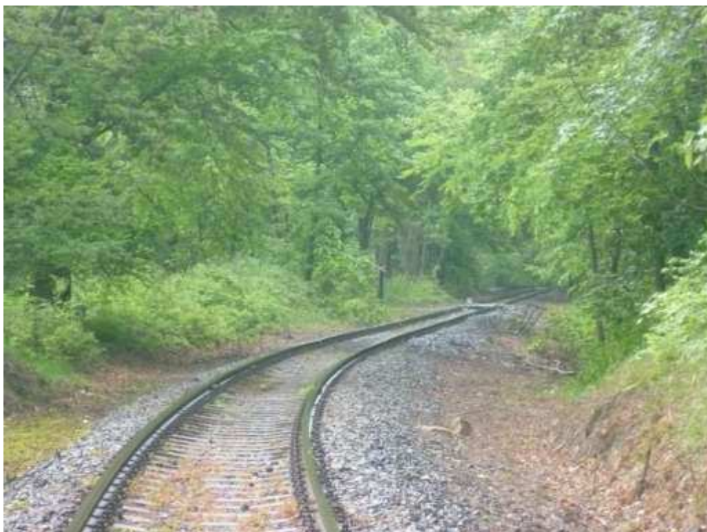
Foto 25: 6 m dlouhá přechodnice oblouku, vymezeném staničními body km 147,024 a km 147,193, pozadí železniční přejezd; pohled ve směru staničení
