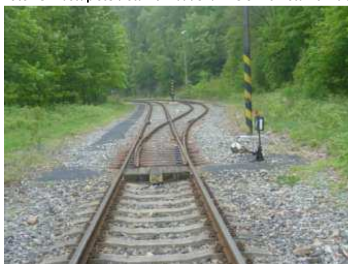
Foto 19: Pohled proti směru staničení na kusé zhlaví stanice Dubí
