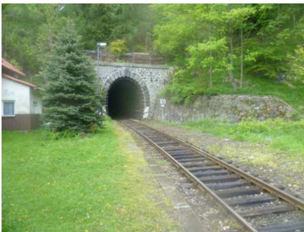
Foto 33: Portál prvního tunelu navazujícího na železniční zastávku Mikulov v Krušných horách
