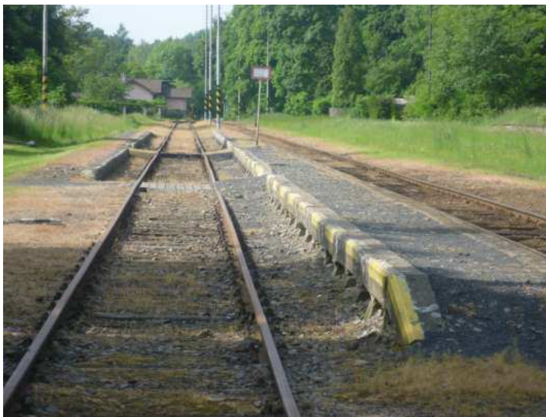
Foto 7: Nástupiště v železniční stanici Osek město; pohled proti směru staničení
