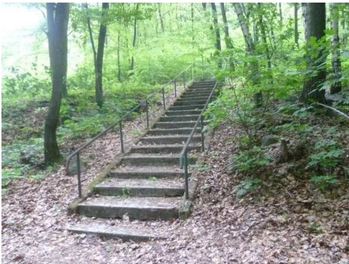
Foto 31: Schodiště vedoucí od přístupové cesty na nástupiště
