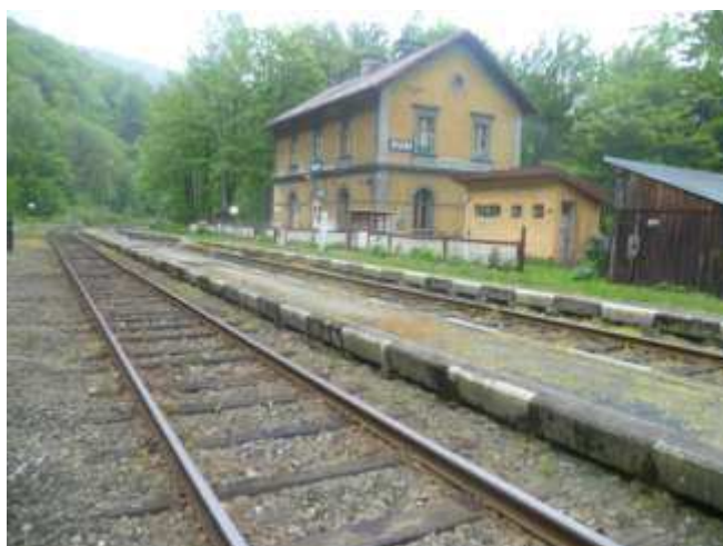
Foto 18: Nástupiště a staniční budova v železniční stanici Dubí
