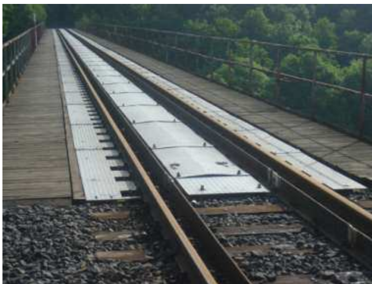
Foto 3: Viadukt ve městě Hrob; pohled ve směru staničení
