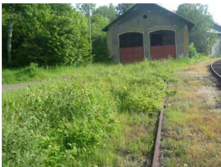
Foto 16: Stavba bývalé výtopy v železniční stanici Hrob
