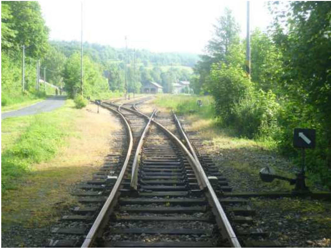
Foto 12: Mostecké zhlaví železniční stanice Hrob; pohled ve směru staničení
