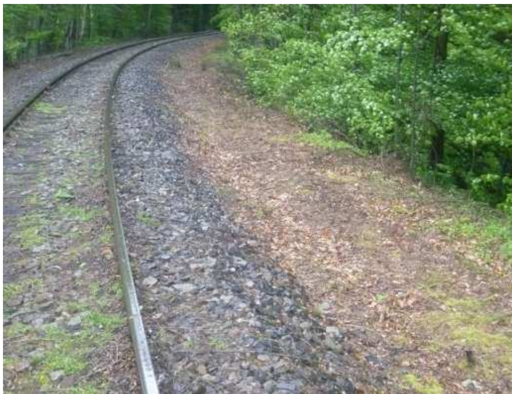
Foto 24: Oblouk vymezený staničními body km 145,677 a km 146,074, u něhož v rámci úprav na zvýšení rychlostí dojde ke zvětšení vrcholového odsazení o 23 mm; pohled ve směru staničení
