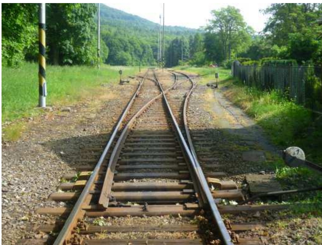
Foto 4: Současná podoba mosteckého zhlaví železniční stanice Osek město; pohled ve směru staničení
