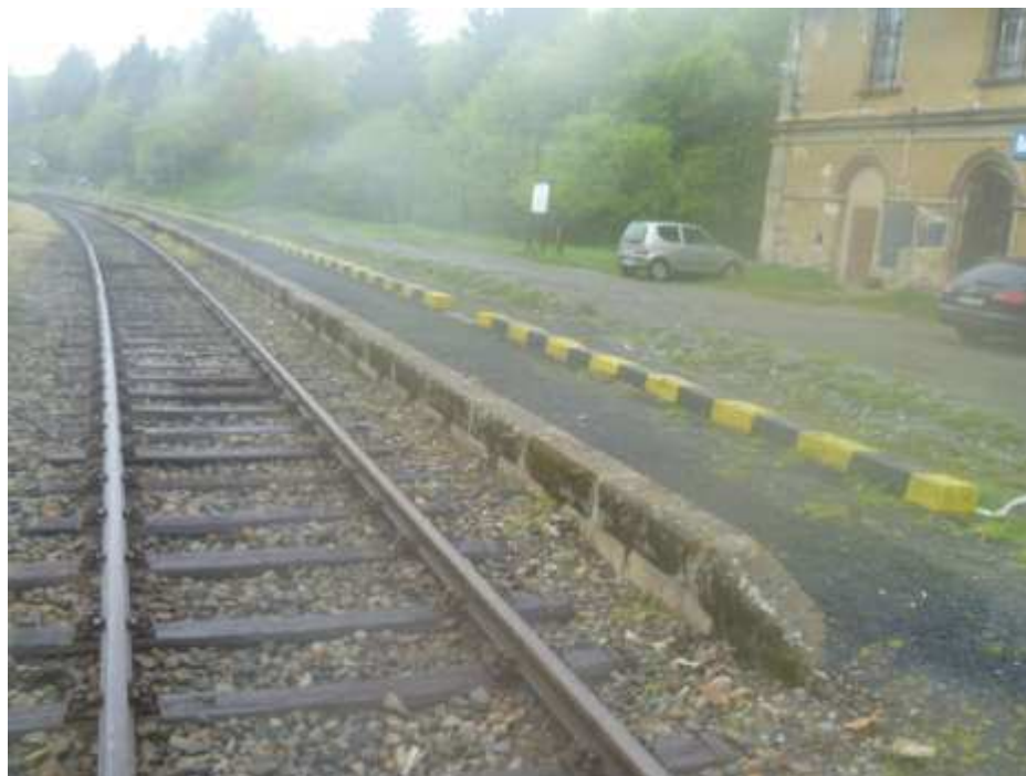
Foto 35: Nástupiště v železniční zastávce Mikulov-Nové město; pohled proti směru staničení
