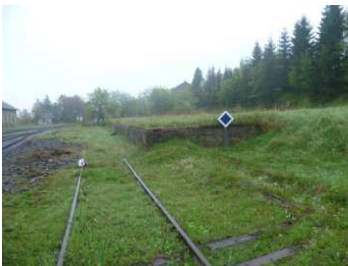
Foto 22: Dnešní stav nakládací rampy v železniční stanici Moldava v Krušných horách
