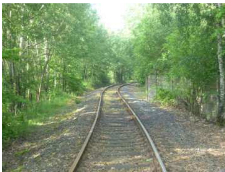
Foto 2: Inflexní bod v km 143,334 za žst. Hrob; pohled ve směru staničení
