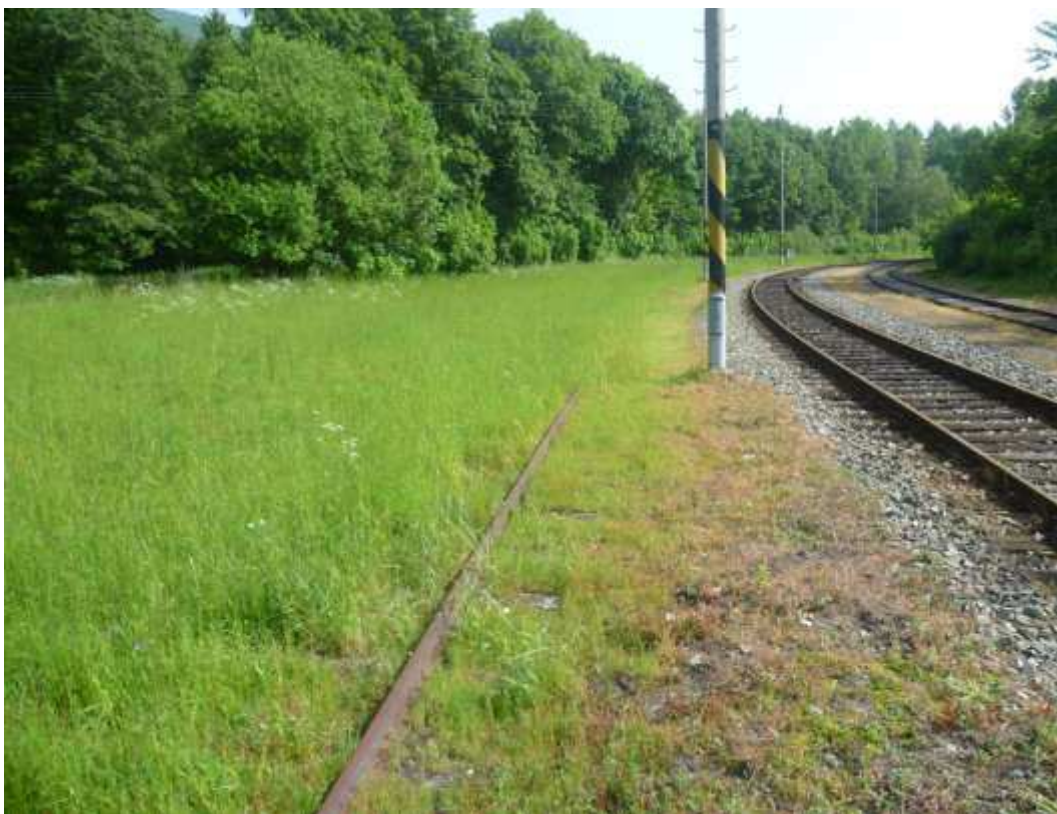
Foto 6: Část staničních kolejí ve stanici Osek město je vedeno do oblouku; pohled ve směru staničení
