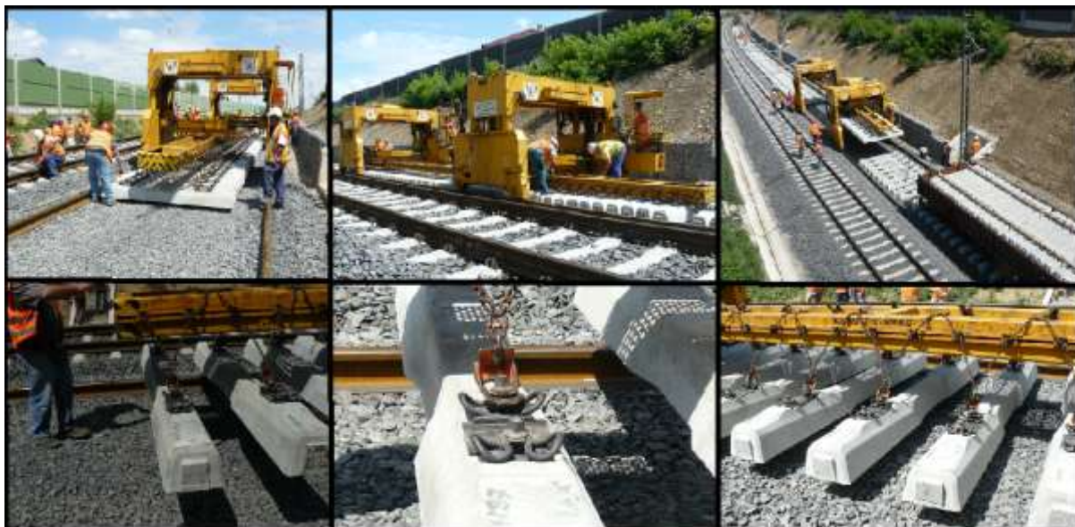
Obrázek 12 Pokladač Donelli PTH 350 při nasazení (Optimalizace trati Stříbro - Planá u M.L.), (zdroj: Ing. Marcinko Andrej)
