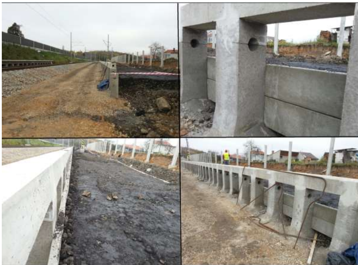
Obrázek 5 Výstavba nástupiště (zdroj: autor)
