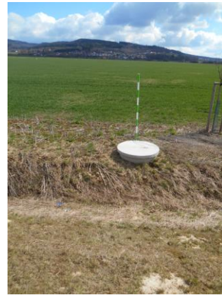
Obrázek 101 - Detail skruže 4 (foto Sysala 2015)
