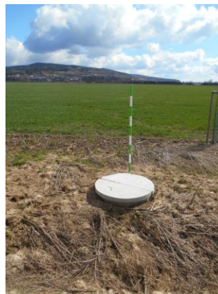
Obrázek 97 - Detail skruže 3 (foto Sysala 2015)
