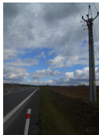
Obrázek 105 - Detail sloupu (foto Sysala 2015)
