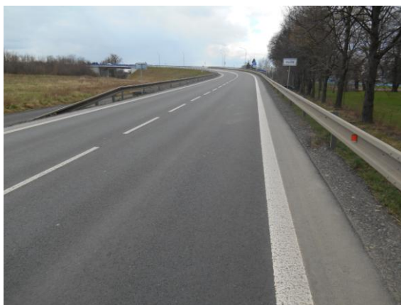
Obrázek 122 - Nevhodný přechod extravilán - intravilán 3 (foto Sysala 2015)
