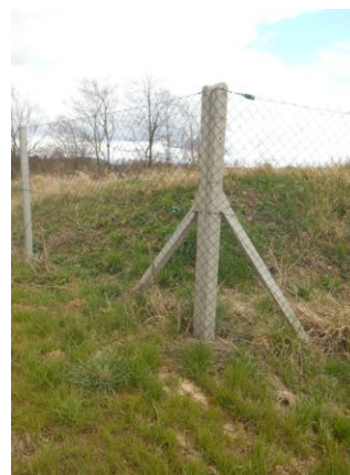
Obrázek 112 - Detail sloupku (foto Sysala 2015)
