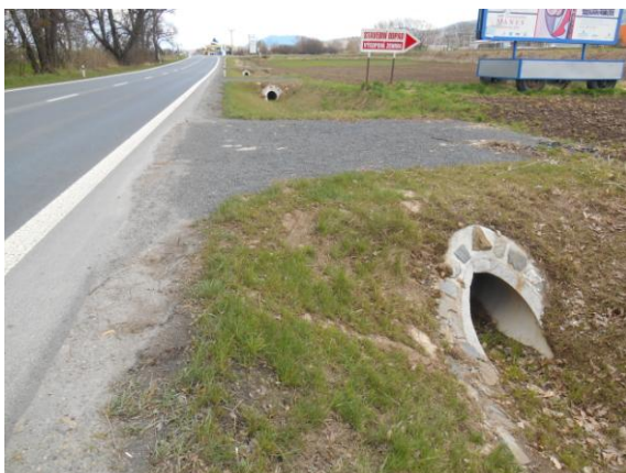
Obrázek 115 - Tuhé čela trubních propustků 2 (foto Sysala 2015)
