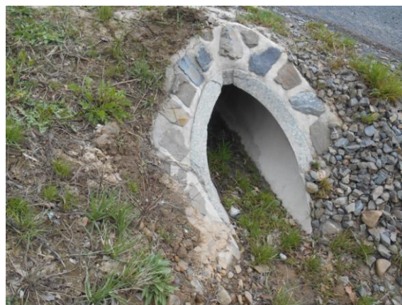
Obrázek 114 - Detail čela propustku 1 (foto Sysala 2015)
