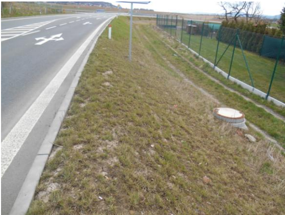
Obrázek 124 - Betonová skruž 5 - 1 (foto Sysala 2015)
