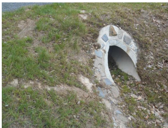
Obrázek 116 - Detail čela propustku 2 (foto Sysala 2015)
