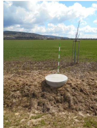
Obrázek 93 - Detail skruže 2 (foto Sysala 2015)
