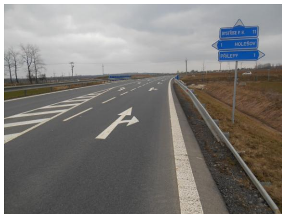
Obrázek 51 - Řazení jízdních pruhů směrem od Zlína (foto Sysala 2015)
