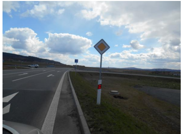
Obrázek 125 - Betonová skruž 5 - 2 (foto Sysala 2015)
