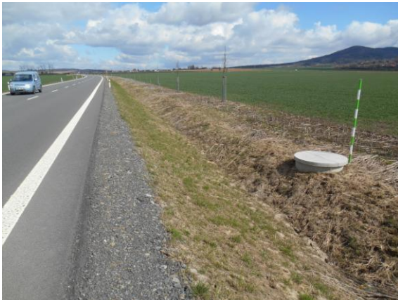
Obrázek 92 - Betonová skruž 2 (foto Sysala 2015)
