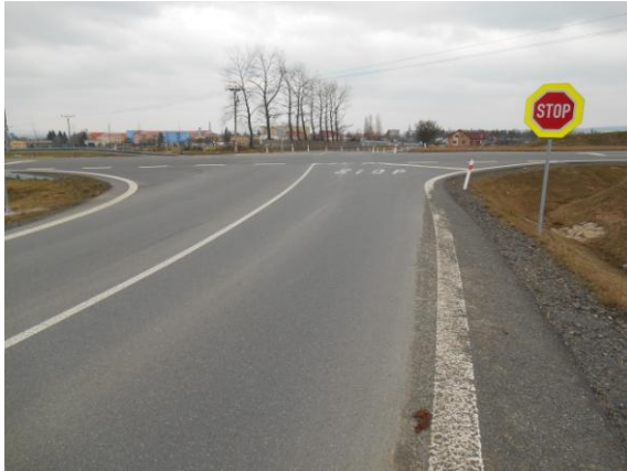
Obrázek 56 - Pohled do křižovatky z ramena od Přílep (foto Sysala 2015)
