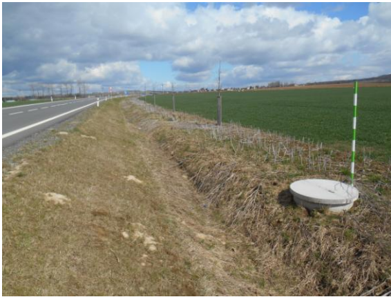
Obrázek 100 - Betonová skruž 4 (foto Sysala 2015)
