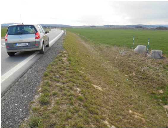
Obrázek 128 - Kovové tyče 5 (foto Sysala 2015)
