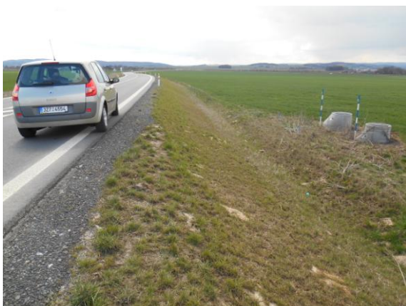
Obrázek 126 - Betonové skruže 6 - 1 (foto Sysala 2015)
