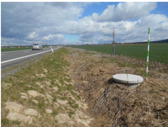
Obrázek 96 - Betonová skruž 3 (foto Sysala 2015)
