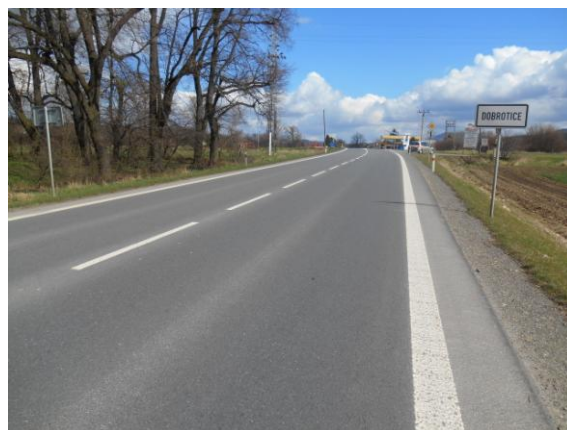
Obrázek 119 - Nevhodný přechod extravilán - intravilán 2 - 1 (foto Sysala 2015)
