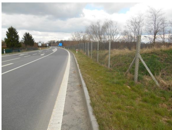
Obrázek 111 - Betonové sloupky oplocení (foto Sysala 2015)
