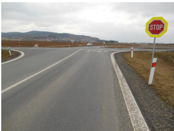
Obrázek 60 - Pohled do křižovatky směrem od Holešova (foto Sysala 2015)
