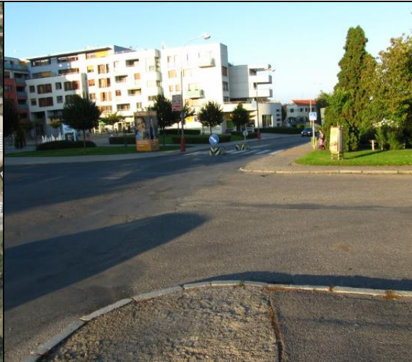
[obr.7] nedostatečně dimenzované nároží zde na protěší straně komunikace místa přizení snímku
