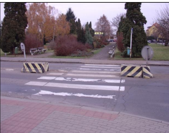
[obr.9] Nepřerušené vodorovné značení V7 a ilustrace rozměrů ostrůvků. Zmísta pořízení snímku vede signální pás přechodu, přičemž na protější straně není ani dostatečně snížený obrubník Zdroj: fotoarchiv autora
