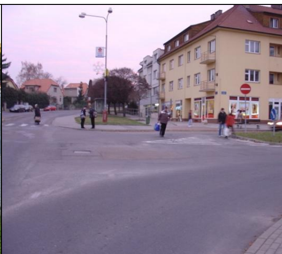
[obr. 13] Důsledek odsazení přechodu z protější strany; zobrazený prostor též v praxi slouží k otáčení vozidel poptávajících parkovací místo
