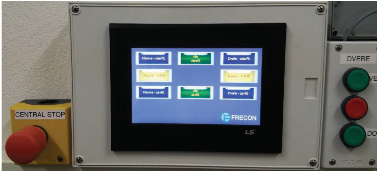
Obr. 31: Ovládací panel otevření/uzavření kalibrační laboratoře
