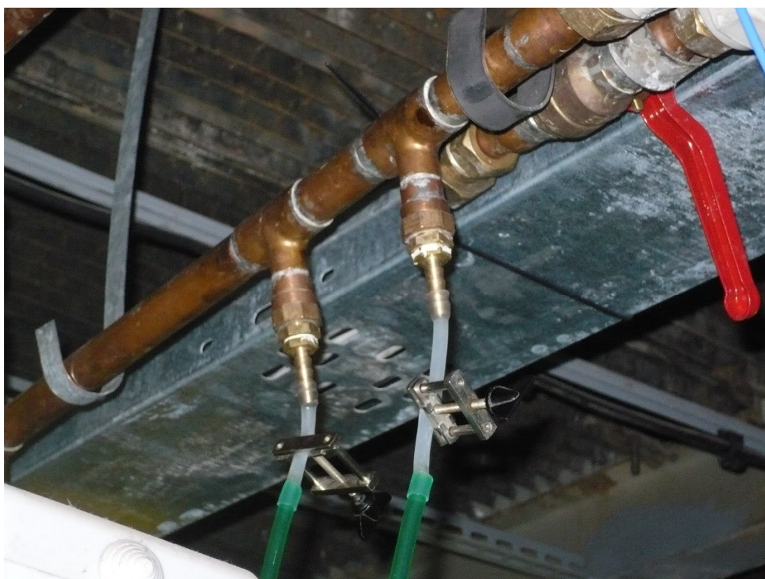
Obr. 4 – Tlakové odběry před vřazeným odporem (kapilární rohoží)
