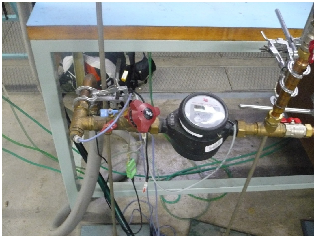
Obr. 1 – Jímka s měřícím čidlem, regulační ventil CRANE D931 DN20 a průtokoměr Recordall M25
