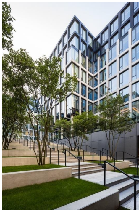
Obr. 4.4 – Pohled na budovu z pasáže [17]
