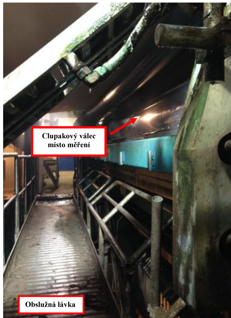
Obr. 20: Místo měření povrchové teploty válce
