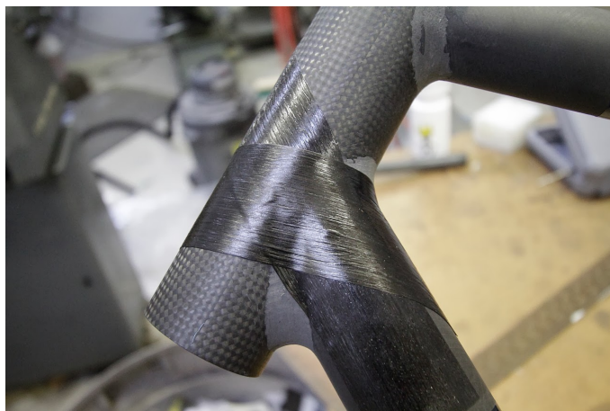
Obrázek 3.12: Detail spoje navíjených trubek [11]
