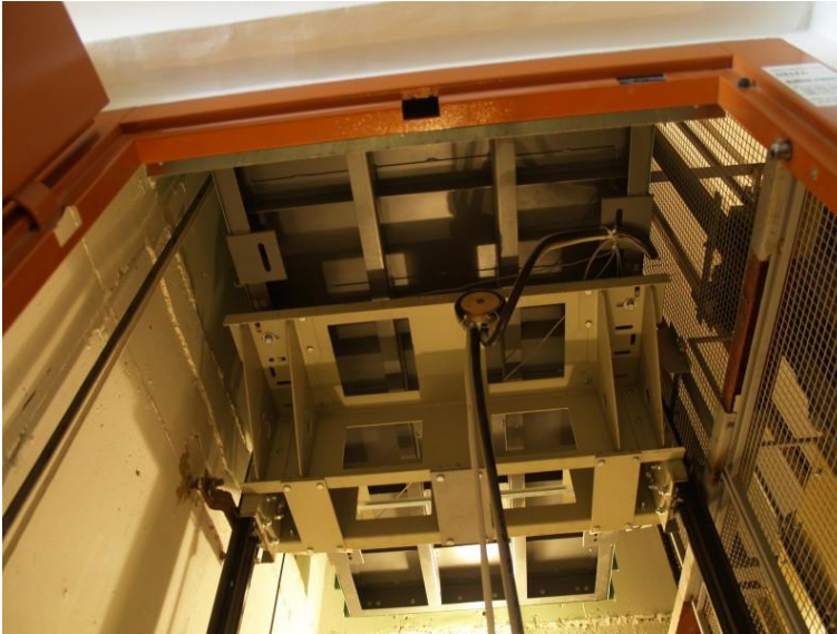
(Obr. 2.8.: Rám kabiny výtahu od firmy Delta CVS. [5])
