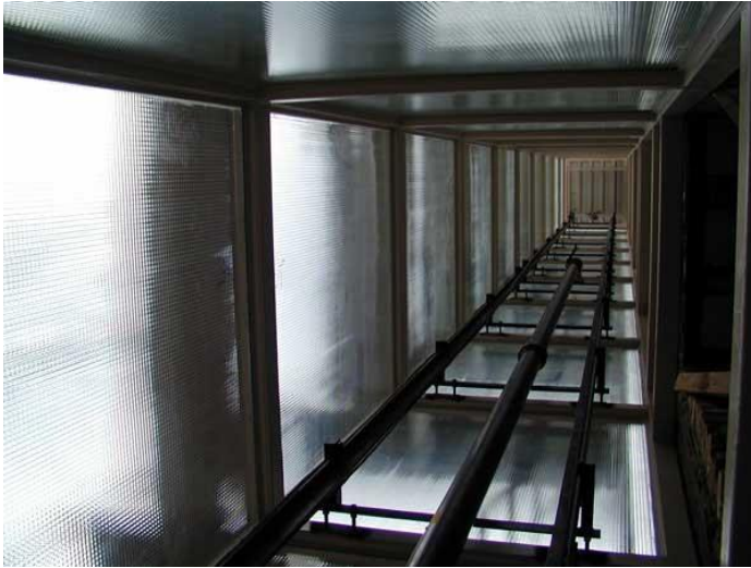
(obr. 1.5.: Výtahové šachta, pohled zesponu dovnitř [4])
