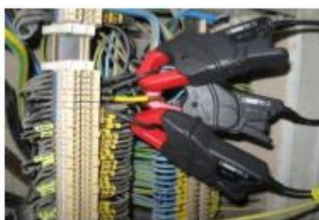
Obr. 9 - Měření na fázi kabelového přívodu
