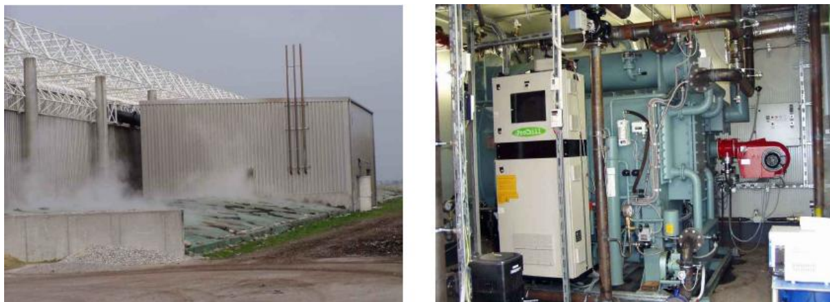
Obrázek 18: Vlevo: Kompostárna zajišťující zdroj tepla pro ATČ, Vpravo: ATČ v provozu kompostárny [22]
