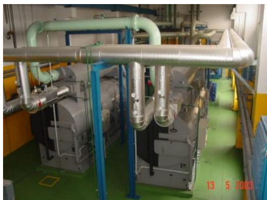
Obrázek 12: Absorpční tepelná čerpadla v areálu Plzeňského Prazdroje [18]
