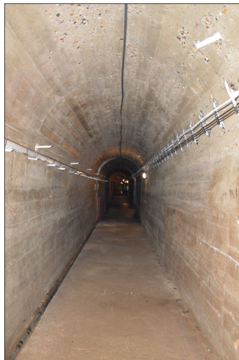
Obrázek 3.1: Chodba vodního díla Orlická
