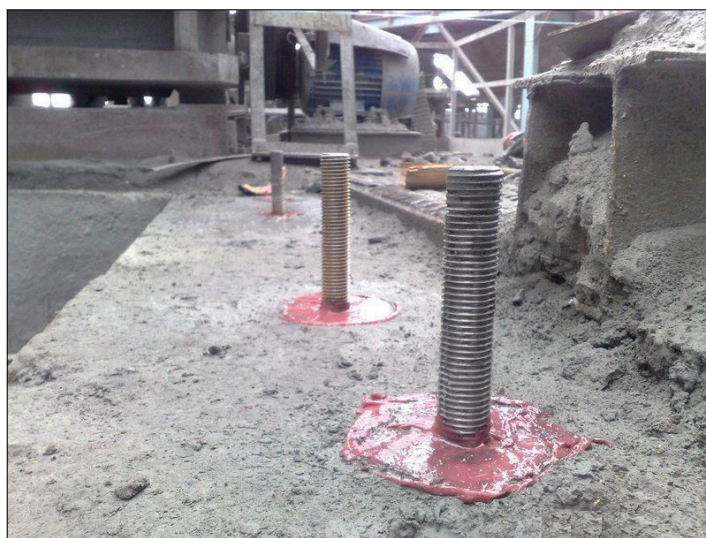
Obrázek 3.13: Příklad použití chemických kotev [almanaracoring.com]
