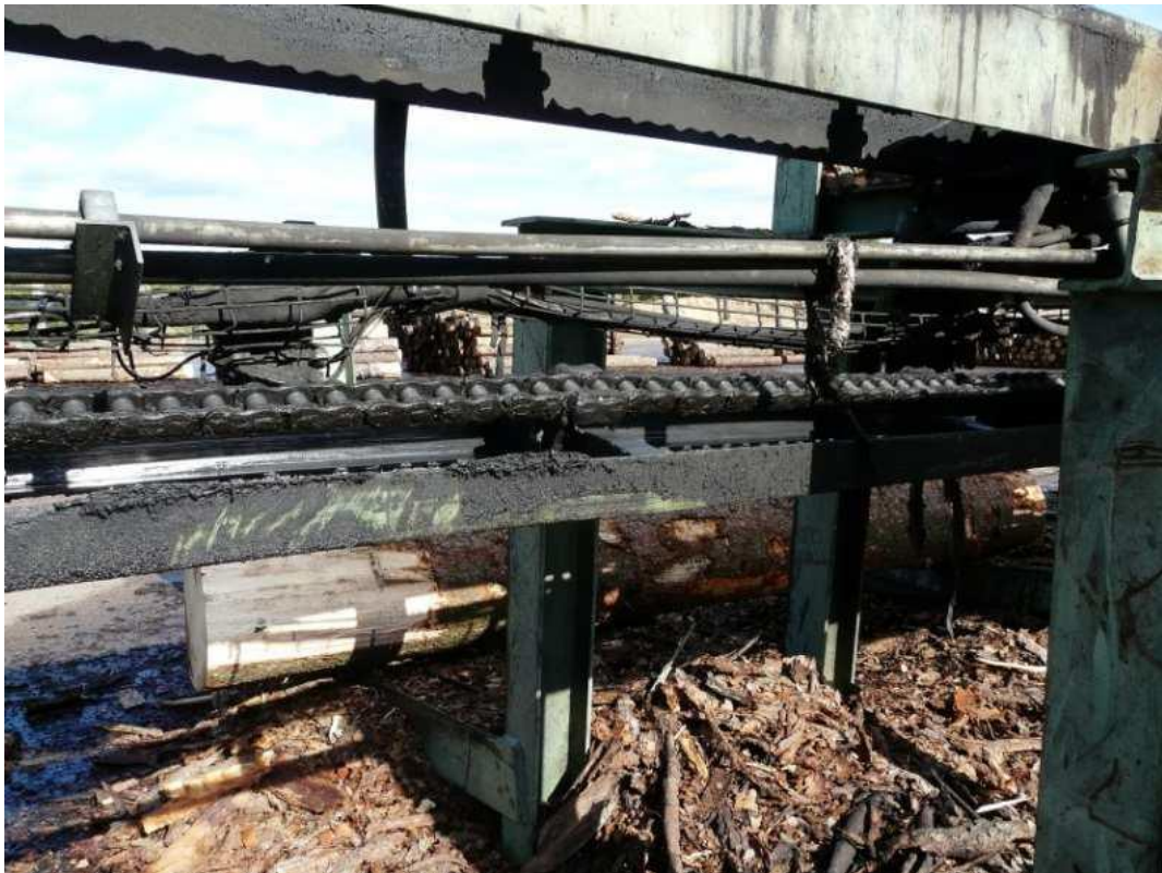
Obr. 2.: Dopravník kulatiny (zdroj: Contra Praha s.r.o.)
