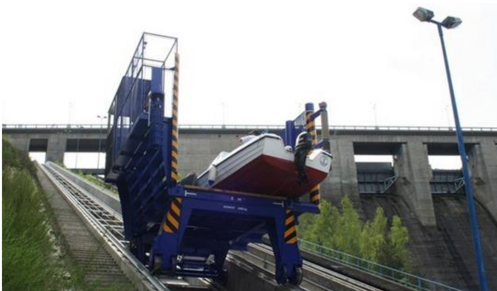
obr. 6.: Šikmé lodní zdvihadlo na vodním díle Orlík – detail přepravního vozíku, [9]
