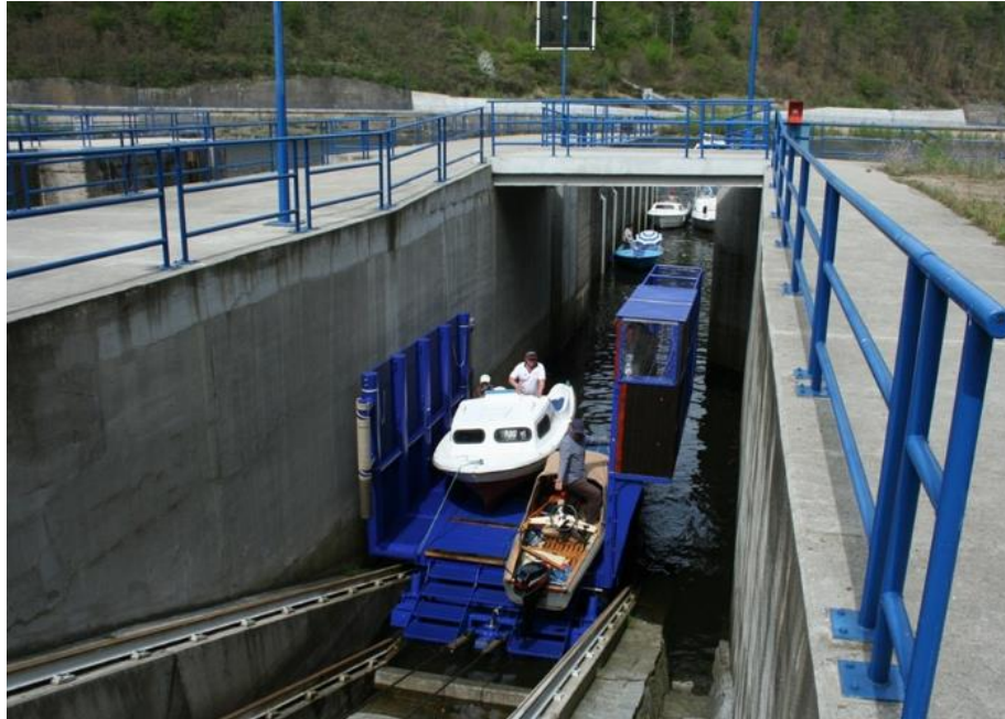
obr. 5.: Šikmé lodní zdvihadlo na vodním díle Orlík – pohled na přepravní vozík u dolní stanice, [8]
