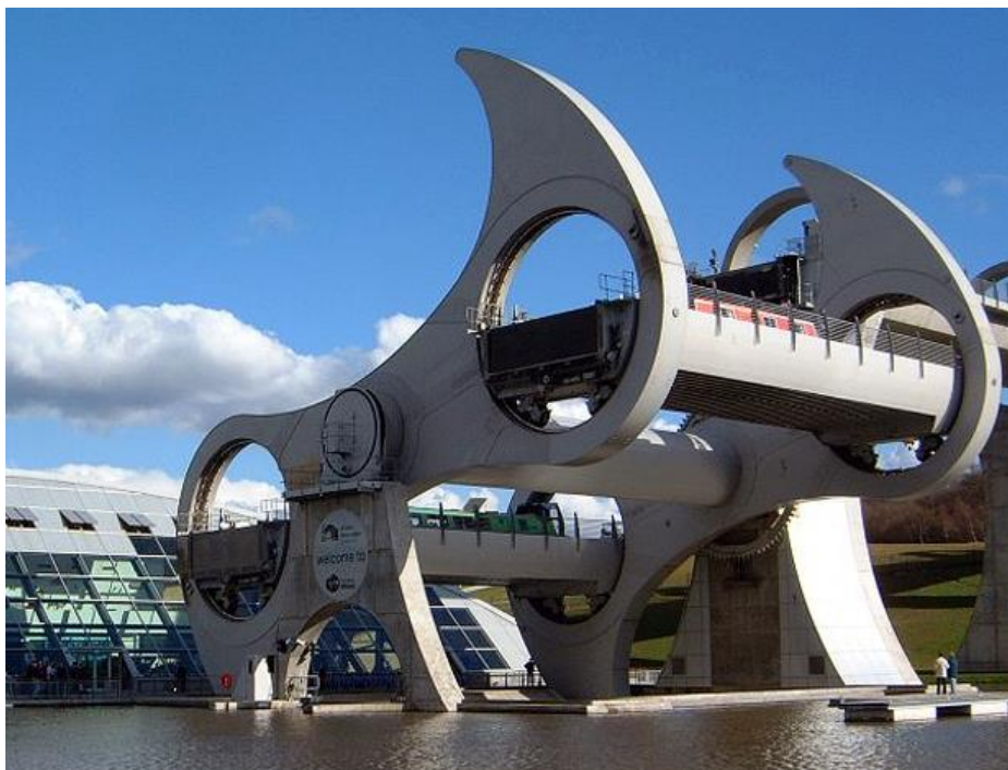
obr. 8.: Rotační lodní zdvihadlo Falkirk Wheel, Skotsko, [13]
