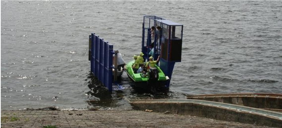
obr. 7.: Šikmé lodní zdvihadlo na vodním díle Orlík – pohled na přepravní vozík v horní stanici, [11]
