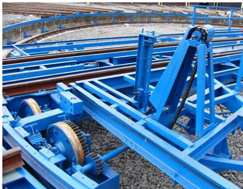
obr. 13.: Ruční pohon železniční točny před montáží podlah, Bohumín, [21]
