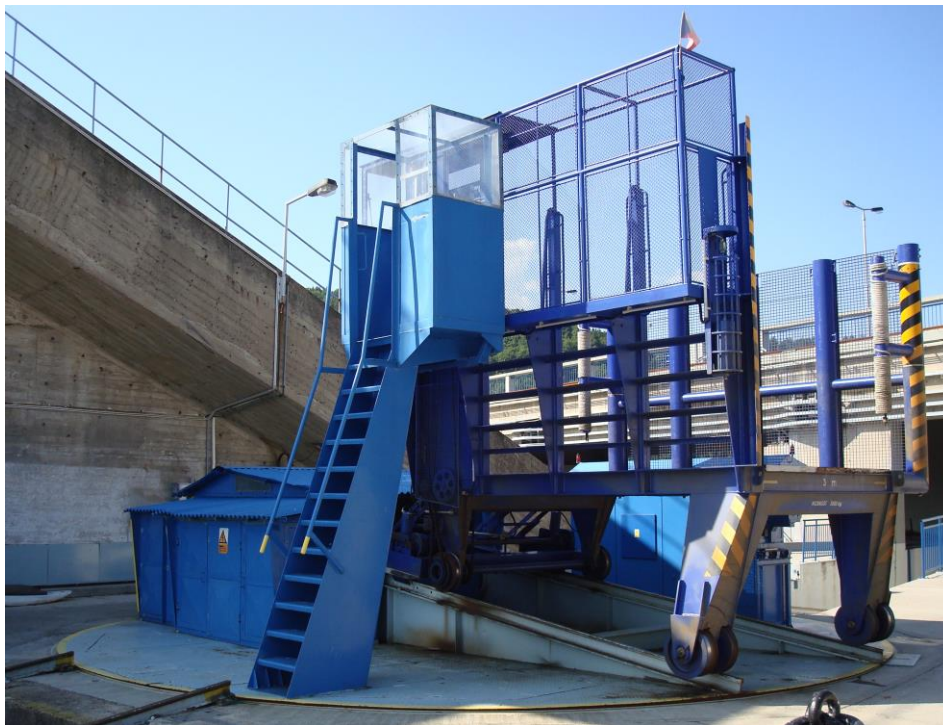
obr. 9.: Točna lodního zdvihadla na přehradě Orlík s vytaženým přepravním vozíkem
