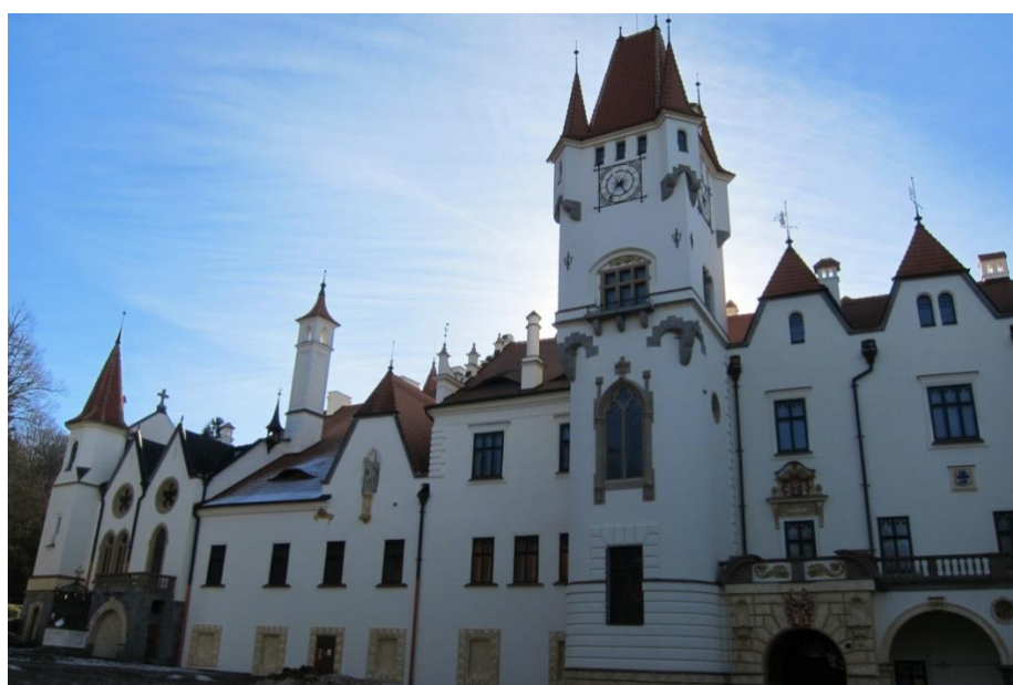
Obr. 80 Žinkovy, zámek, severní průčelí severního křídla zámku (foto autorka)
