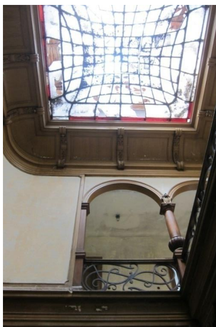
Obr. 119 Koryčany, vila Thonet, řešení stropu schodištní haly (foto autorka)
