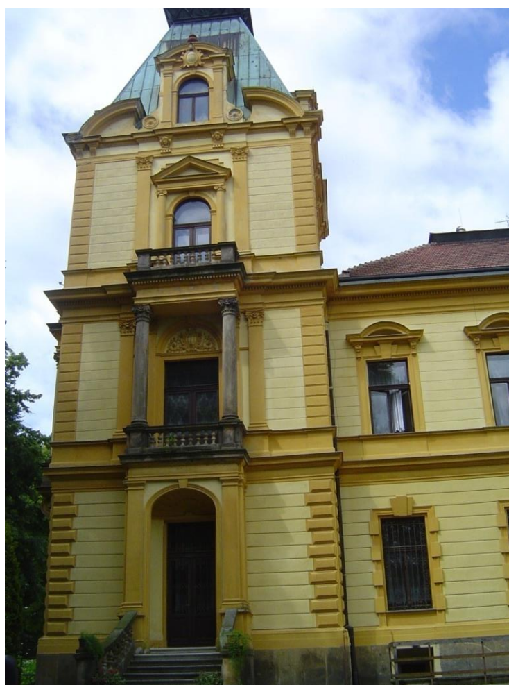
Obr. 45 Pavlovice u Přerova, zámek Alfréda Skene, nárožní věž (foto autorka)
