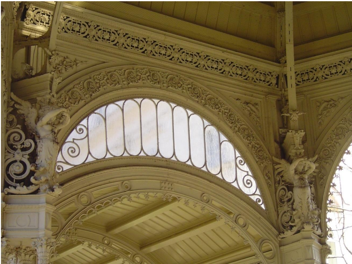
Obr. 12 Karlovy Vary, kolonáda u Sadového pramene, současný stav – detail (foto autorka)
