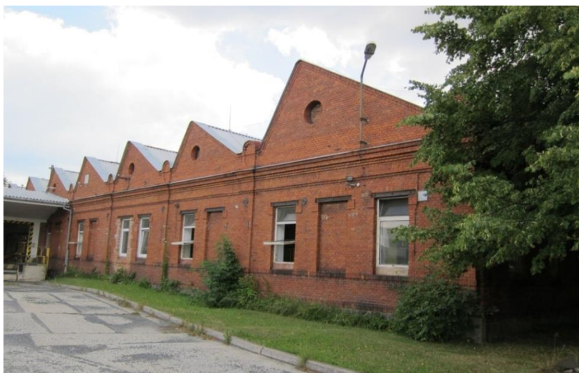
Obr. 121 Vítkov, hedvábnická továrna Trebitsch a syn, zachovalá Fellnerem & Helmerem navržená část hal se shedovými střechami (foto autorka)
