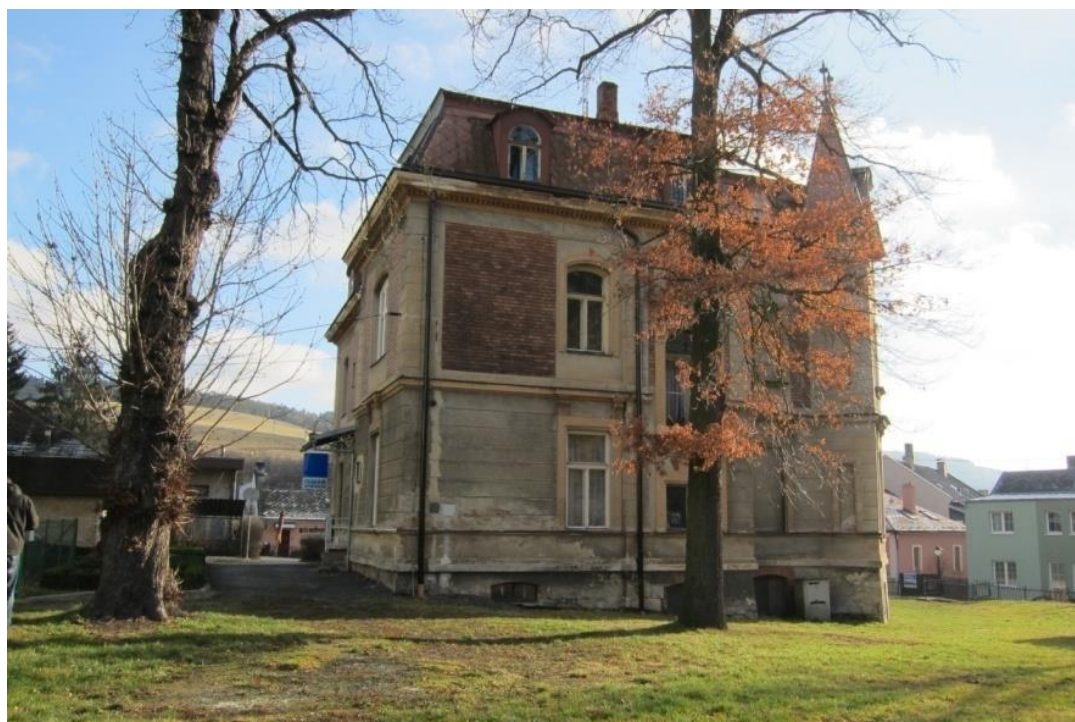
Obr. 75 Moravská Chrastová, vila Bader, východní průčelí, vzhled z roku 2012 (foto autorka)
