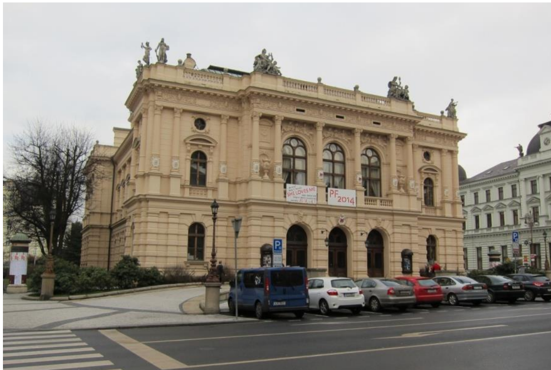
Obr. 17 Liberec, divadlo F. X. Šaldy, hlavní průčelí, současný stav (foto autorka)
