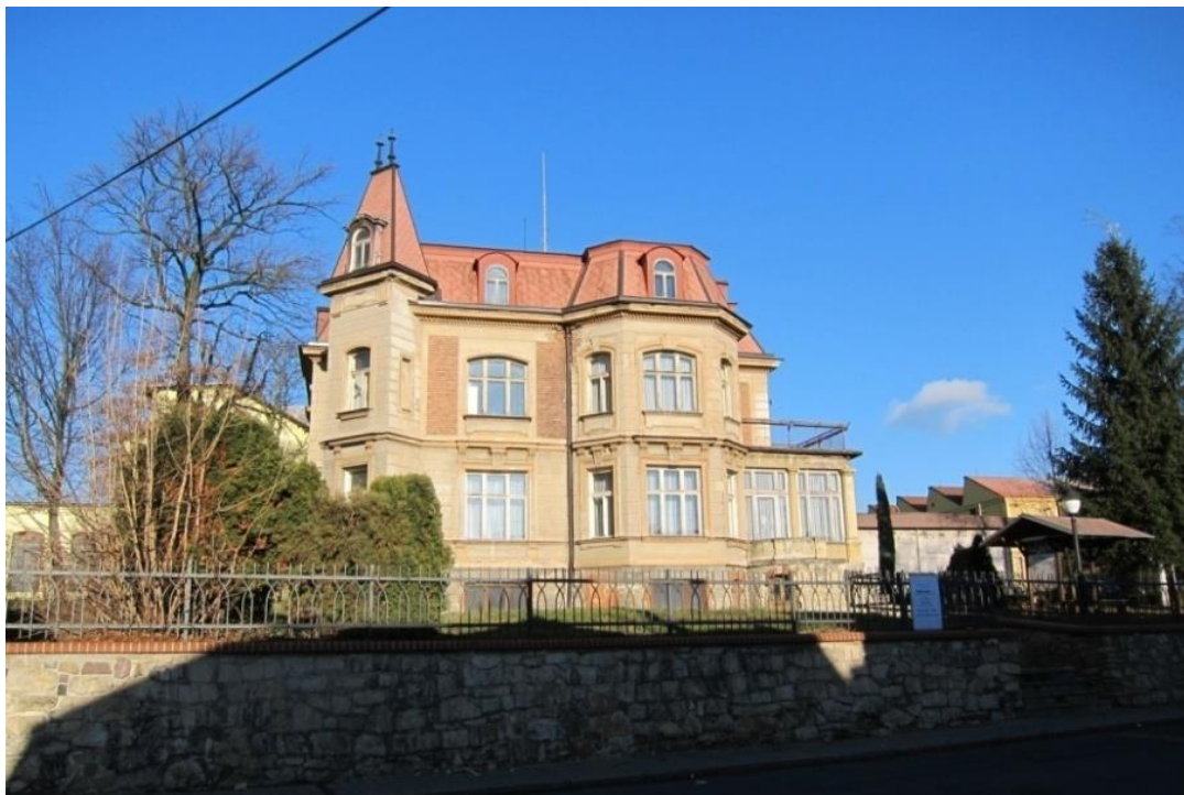
Obr. 74 Moravská Chrastová, vila Bader, jižní průčelí - vzhled z roku 2012 (foto autorka)
