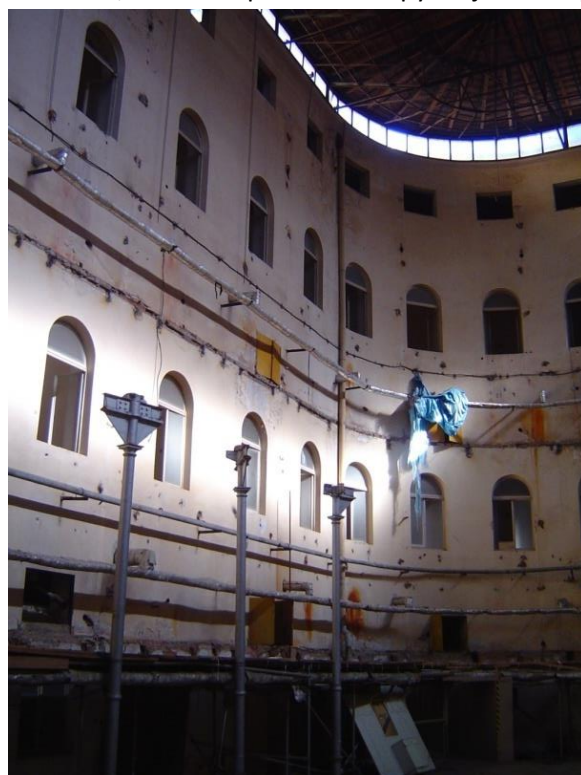
Obr. 69 Karlovy Vary, Císařské lázně, vnitřní dvůr s okny a otvory pro zavážení rašeliny do jednotlivých lázní (foto autorka)
