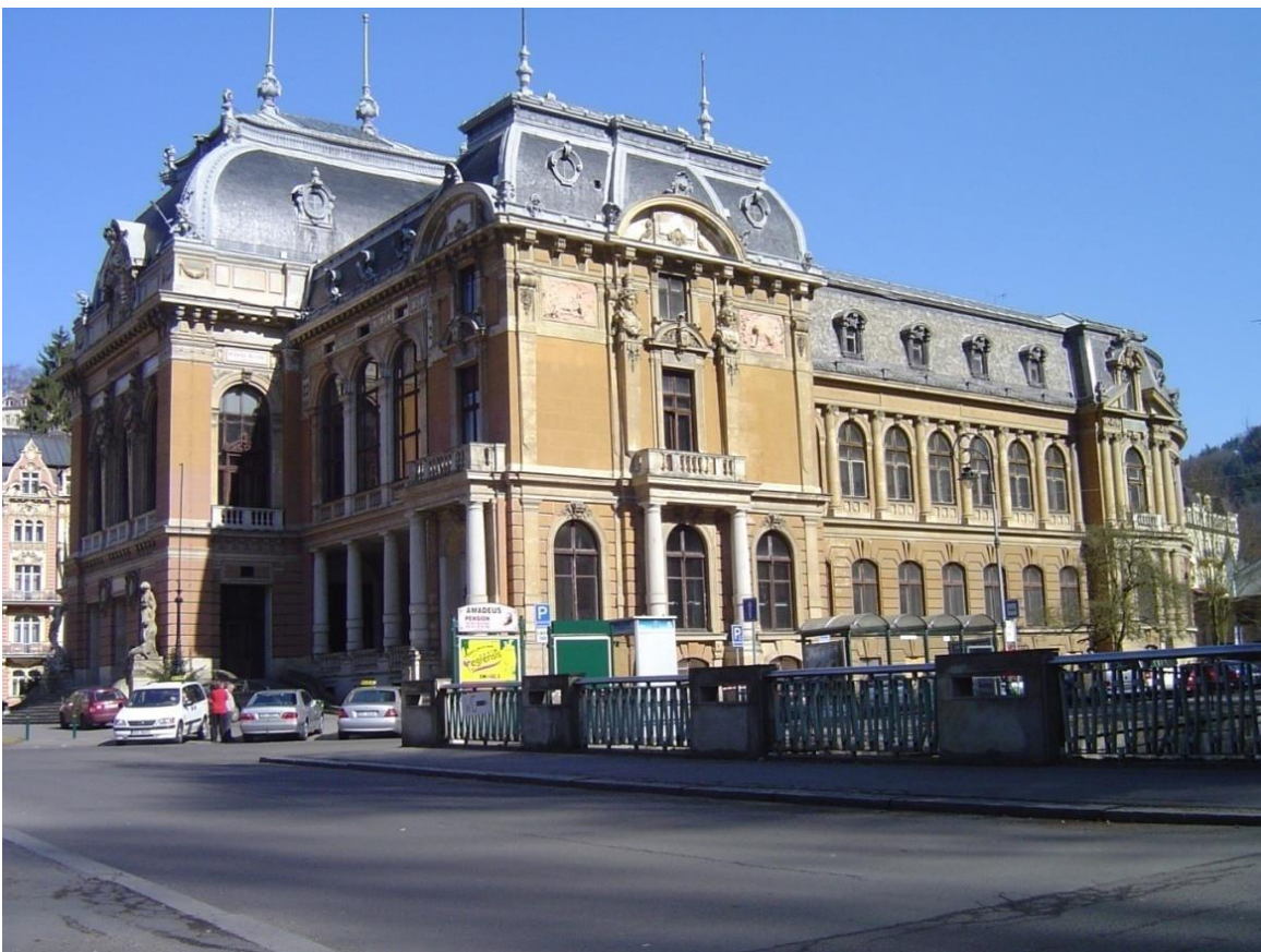
Obr. 65 Karlovy Vary, Císařské lázně, boční fasáda směrem k říčce Teplé (foto autorka)
