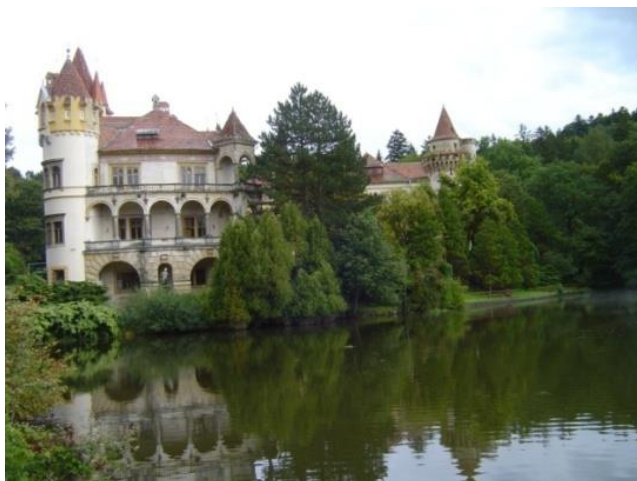
Obr. 79 Žinkovy, zámek, jižní průčelí severního křídla zámku (foto autorka)
