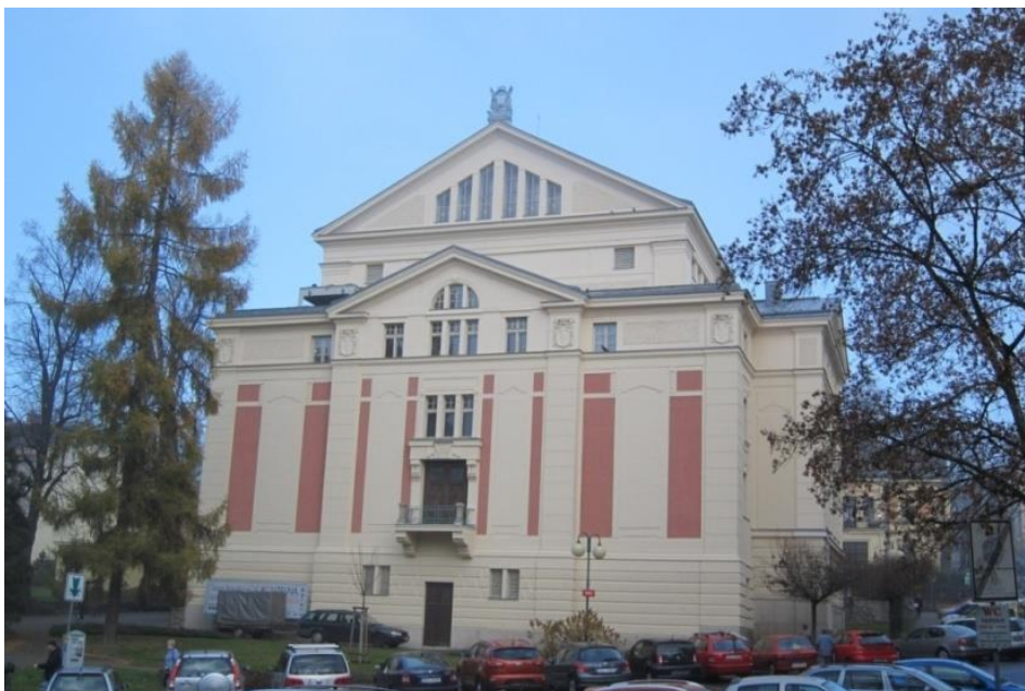
Obr. 125 Jablonec n. N. divadlo, pohled od jihu (foto autorka)
