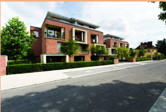
Obr. 18 – 20 Součástí každého bytu je lodžie, na kterou se vstupuje francouzským oknem. Jeho spodní lišta je však vyšší než 20 mm a vytváří bariéru pro vstup osoby na vozíku (detail vpravo dole; foto Pavel Lupač 3x).
