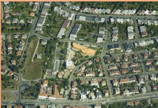
Obr. 57 Dům seniorů Hvězda se nachází v klidné obytné zástavbě, přitom na atraktivním místě v rámci města. Měřítkem však budova neodpovídá okolním rodinným domům. Foto Google Maps.
