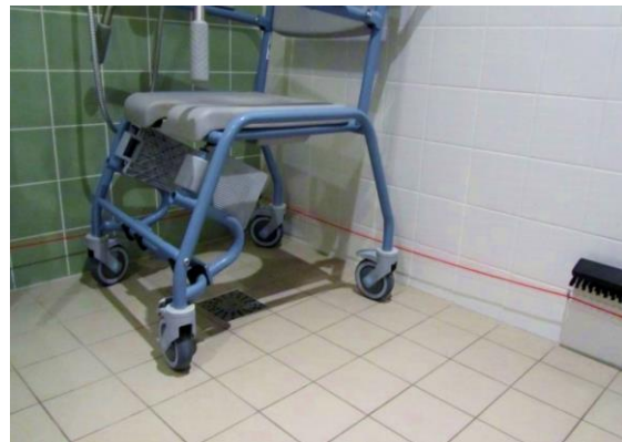
Obr. 40, 41 Pohled do bezbariérové koupelny se signalizačním zařízením, které je v případě pádu dosažitelné z jakéhokoli místa pomocí provázku napnutého těsně nad podlahou. (Kadoelbreek, Amsterdam, Nizozemsko)
