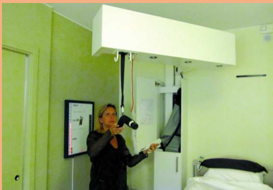
Obr. 12 Zdvihací zařízení je elegantně skryté ve skříňce.
