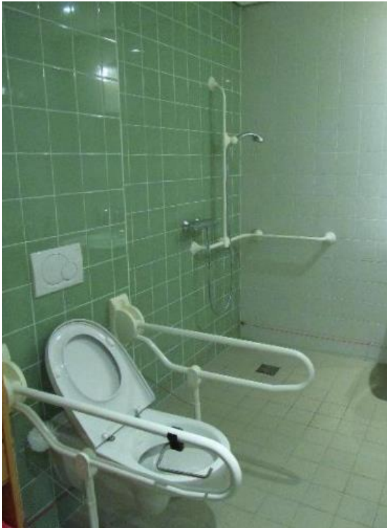
Obr. 40, 41 Pohled do bezbariérové koupelny se signalizačním zařízením, které je v případě pádu dosažitelné z jakéhokoli místa pomocí provázku napnutého těsně nad podlahou. (Kadoelbreek, Amsterdam, Nizozemsko)
