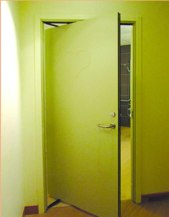
Obr. 14 Dveře do koupelny jsou díky zvláštnímu mechanismu otevíratelné v plné šíři na obě strany. Manipulace s nimi je tak snadná i pro osobu na vozíku.
