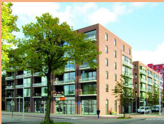
Obr. 49 Exteriér budovy. V přízemí se nachází veřejně přístupná restaurace.
