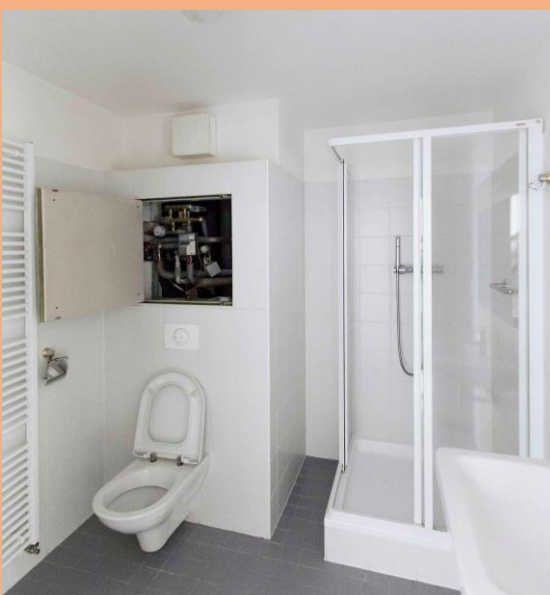
Obr. 21 Vestavěný sprchový kout nevyužívá dostupný výklenek v celé šířce a ponechává tak volný prakticky nevyužitelný prostor a komplikuje prostorové uspořádání koupelny. Vanička je navíc příliš vysoká a neumožňuje použití osobou upoutanou na vozík nebo osobou s výraznějším pohybovým omezením.
