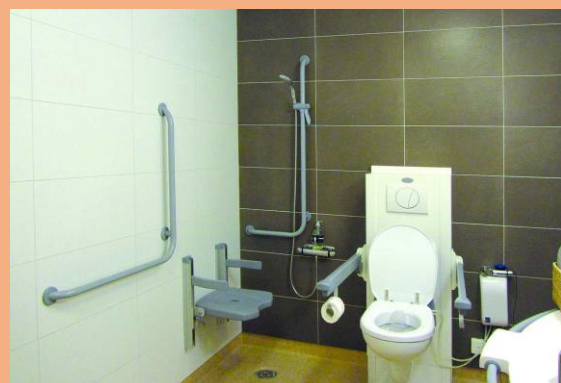
Obr. 13 Toaleta je jednoduše výškově nastavitelná pomocí tlačítek, stejně jako umyvadlo a některá madla, a to i během používání.
