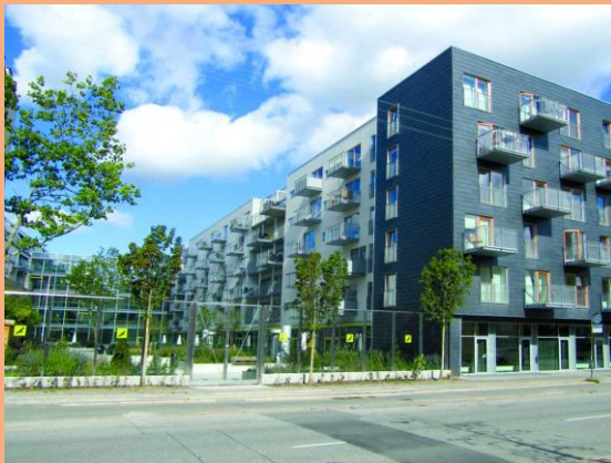
Obr. 101, 102 Budova Fælledgården byla rekonstruována v letech 2012 – 2013. Nachází se na východě Kodaně, v hustě obydlené čtvrti s převládající blokovou zástavbou. (Situace HERE Maps .)
