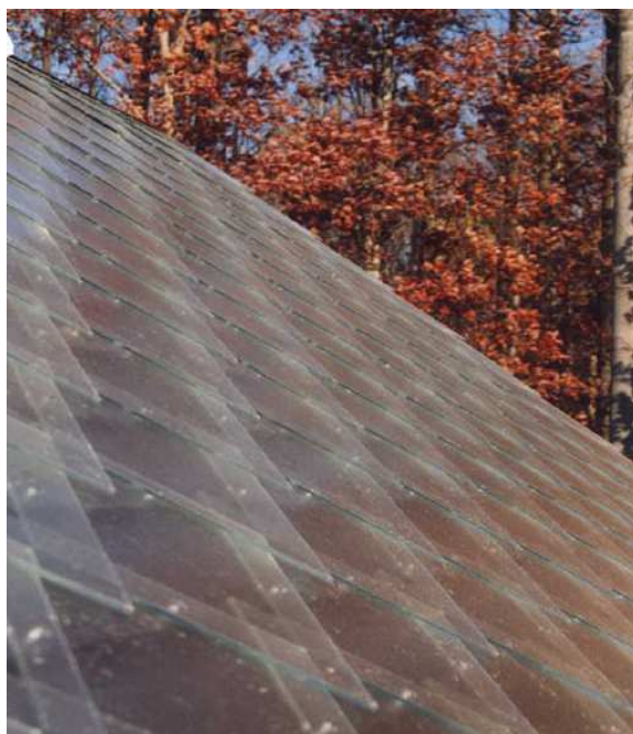
Zakrytý prosklený vzduchový střešní kolektor, zdroj: American Solar http://www.americansolar.com/
