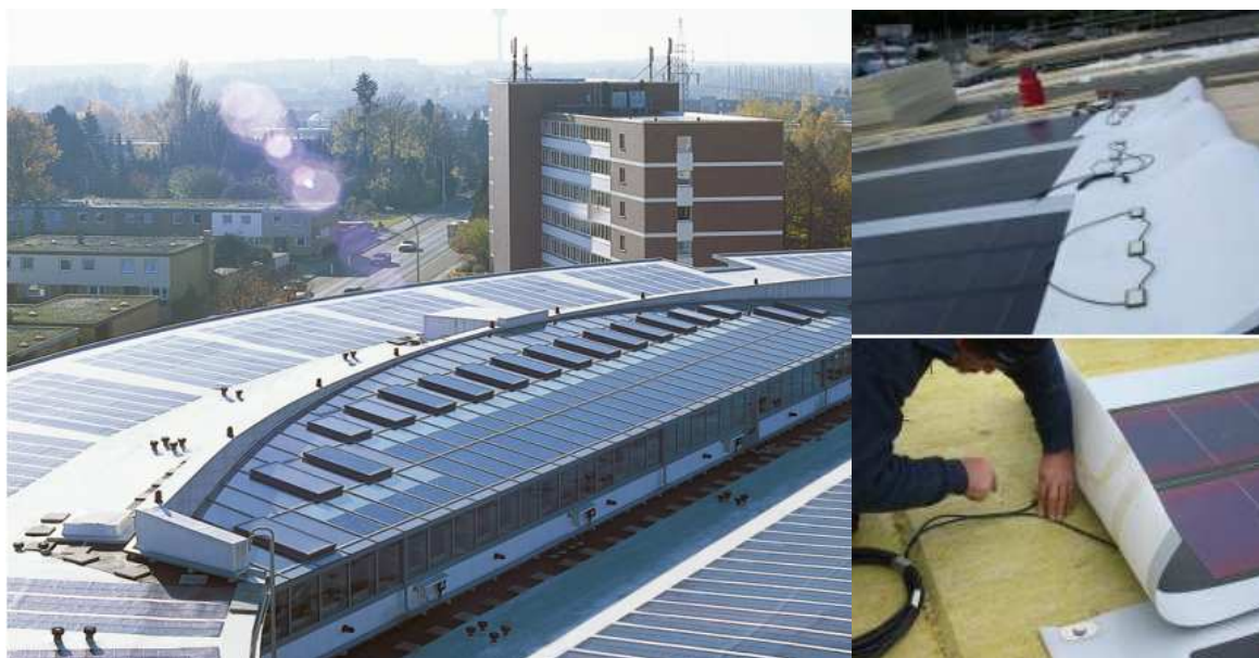
EVALON-Solar, integrovaný hydroizolační a fotovoltaický systém pro ploché střechy, zdroj: FDT (CZ), s.r.o., http://www.fdt.cz/
