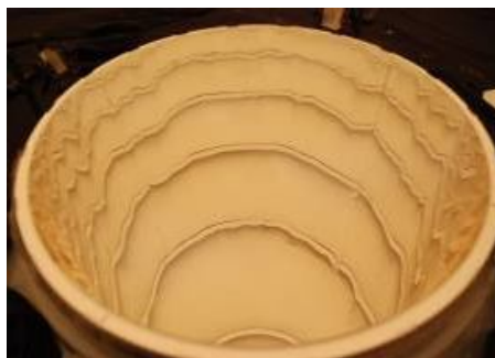
Obrázek 21: Pohled na stěnu světlovodu s osazeným difuzorem, větší úhel pohledu
