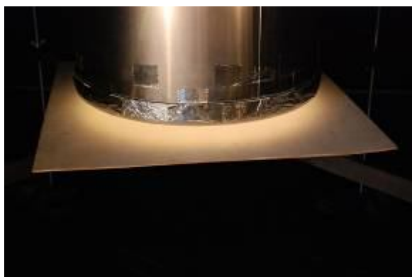
Obrázek 19: Pohled na difuzor, který byl po okraji přelepen hliníkovou páskou a demonstrace osvětlení těsně pod difuzorem
