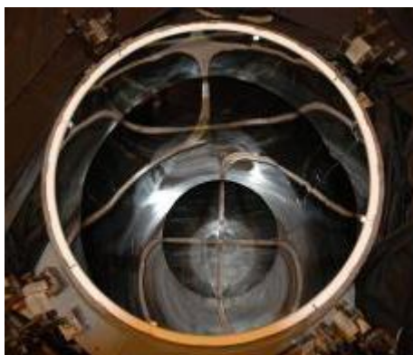
Obrázek 14: Pohled do světlovodu, na spodu patrný vodící kříž a na podlaze sametová látka
