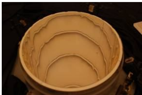
Obrázek 20: Pohled na stěnu světlovodu s osazeným difuzorem
