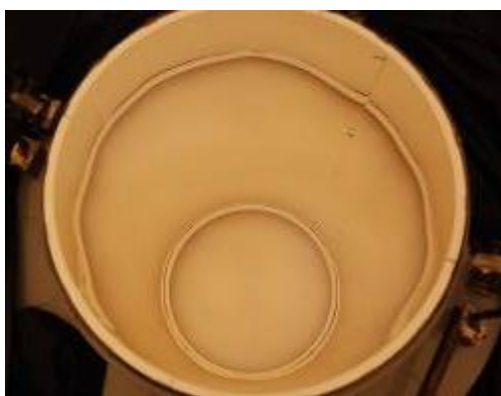
Obrázek 22: Pohled do světlovodu s difuzorem na spodní hraně
