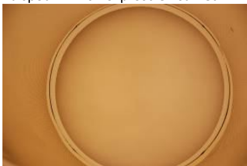
Obrázek 27: Pohled do světlovodu, na spodním líci osazen difuzor
