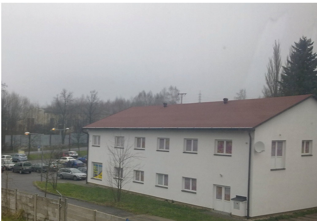
Obr. 10 : Fotografie střechy objektu, uvažované pro umístění FV panelů
