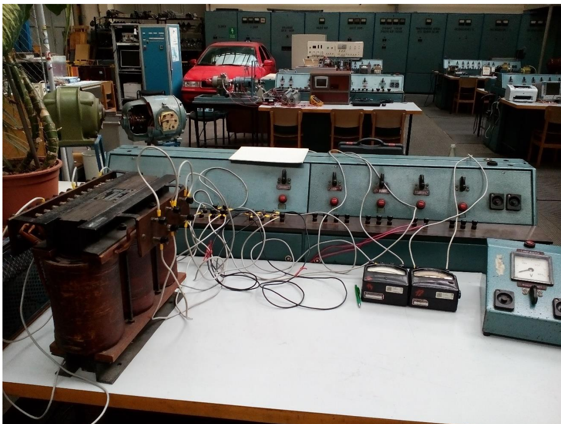
Příloha č. 5 Měření se symetrizačním autotransfornátorem
