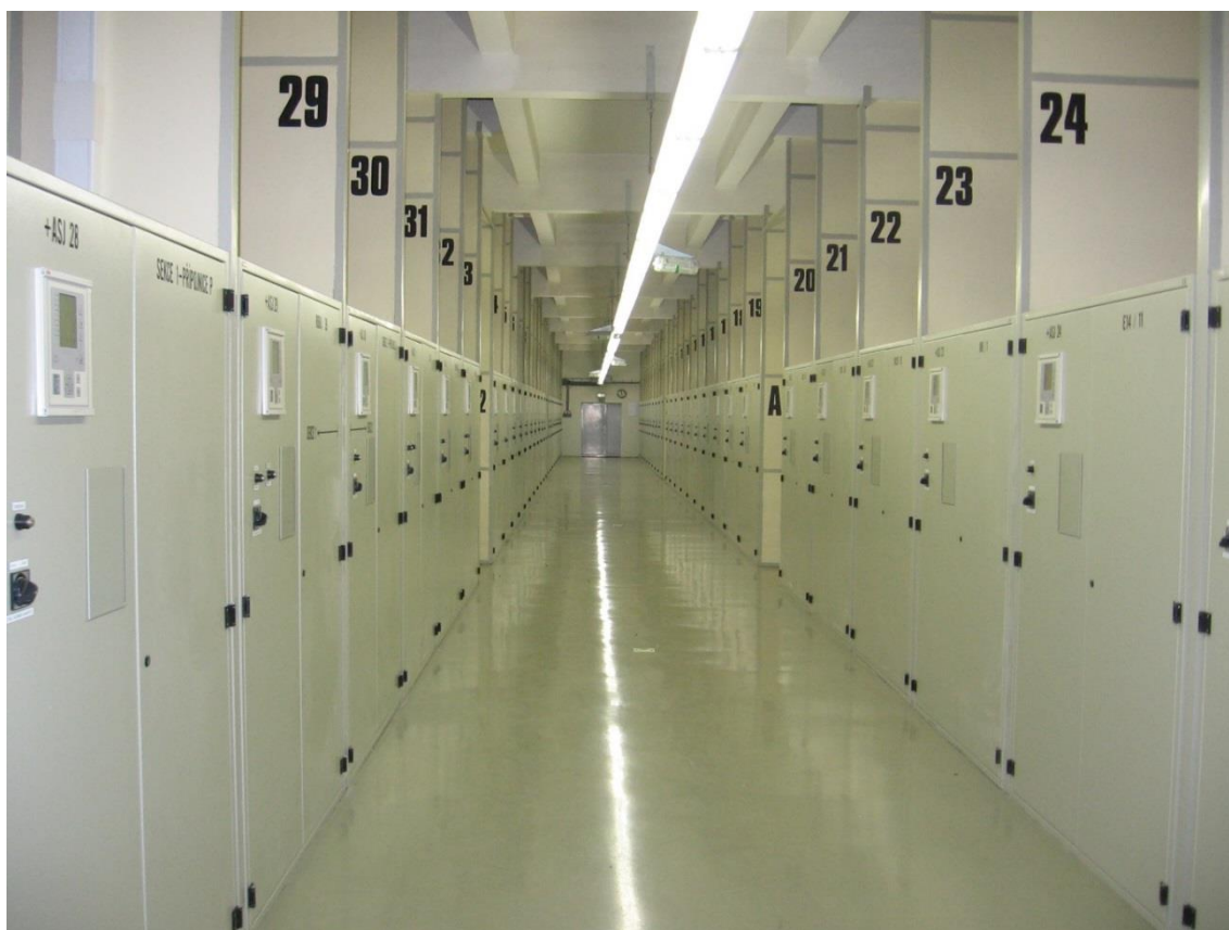
Obrázek 4: Rozvodna 22 kV
