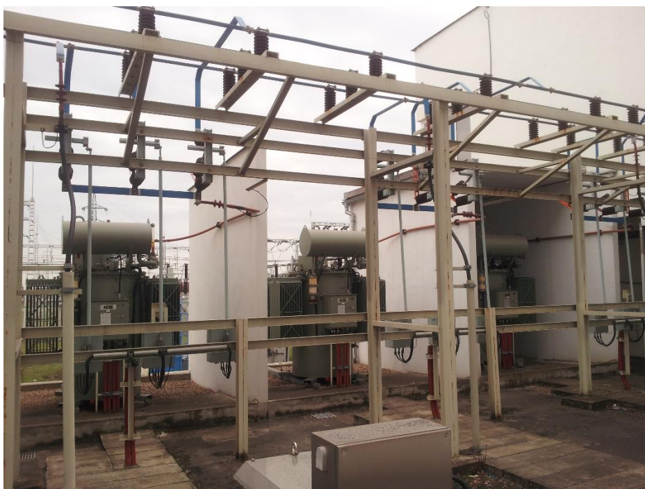
Obrázek 6: Tlumící cívky
