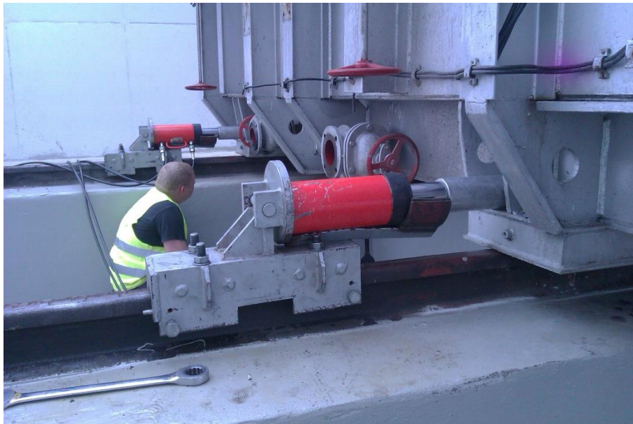
Obrázek 7: Hydraulické heverování transformátoru
