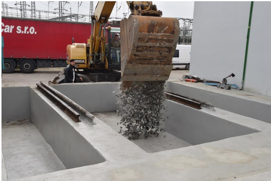
Obrázek 8: Zасыpávání záchytných jímek
