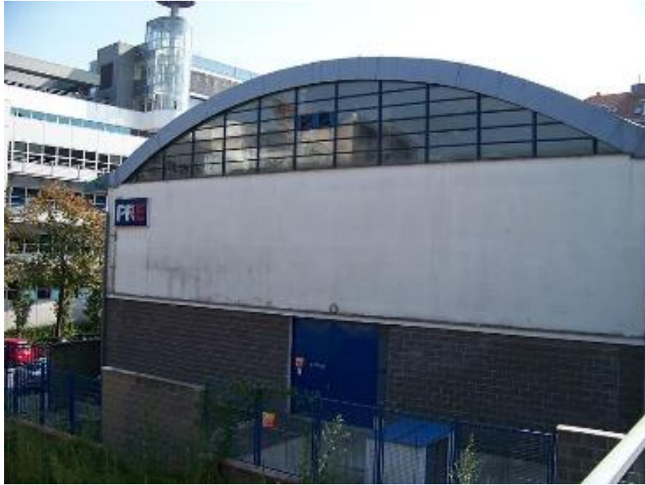
Obraz 11: Rozvodna Smíchov
