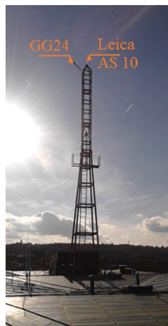
(b) Anténní stožár, anténa AS10 je na vrcholu stožáru
