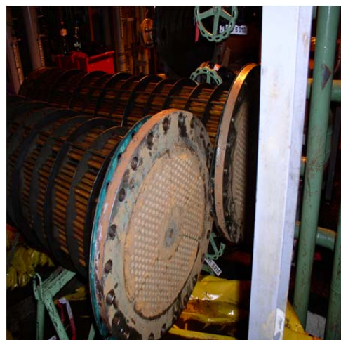
Obr. 15 Pohled na vnitřní trubkovnici výměníku [zdroj: vlastní zpracování]
