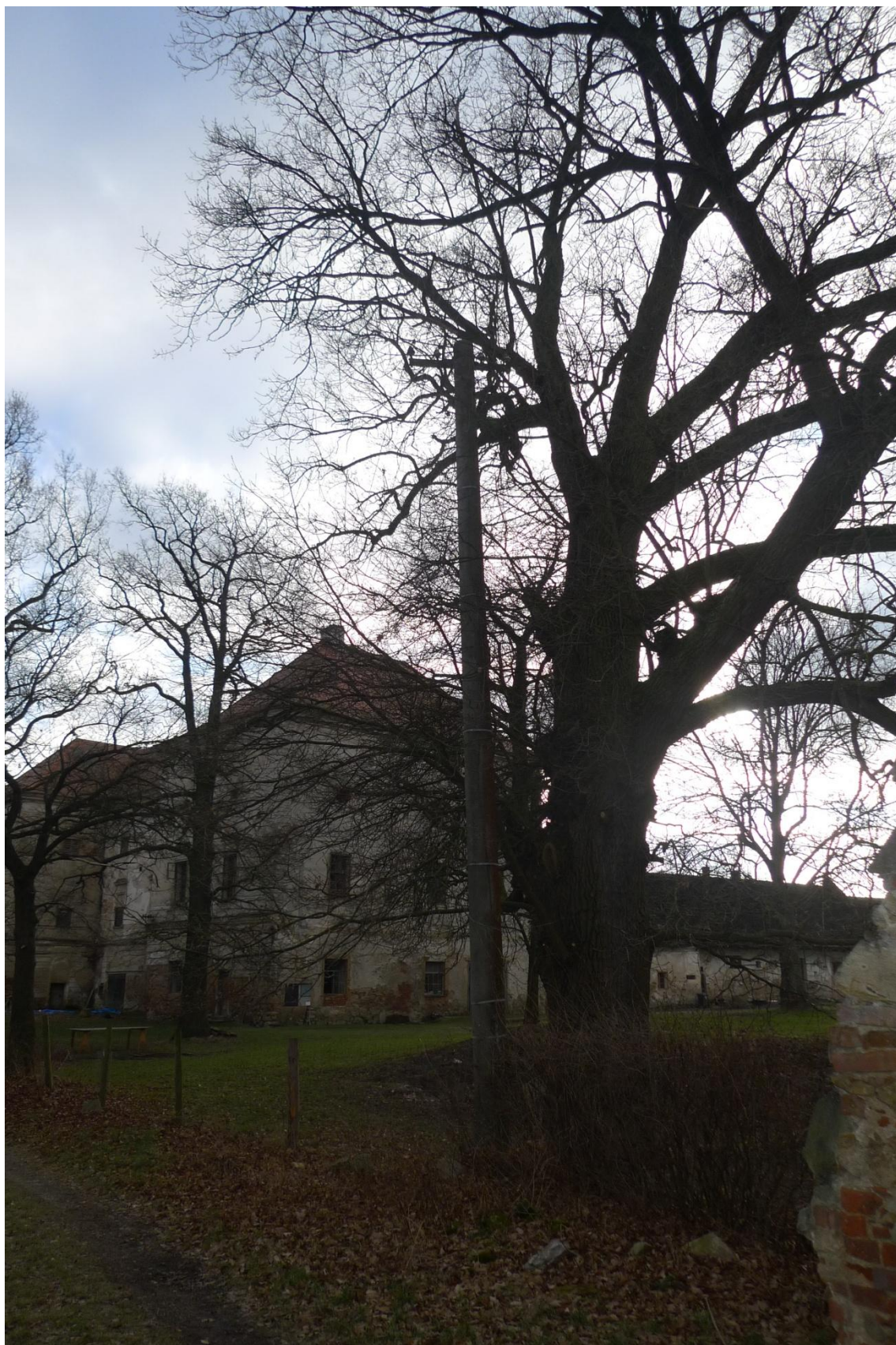
Příloha 3 – Sloup vedení u stromu, foto – autor
