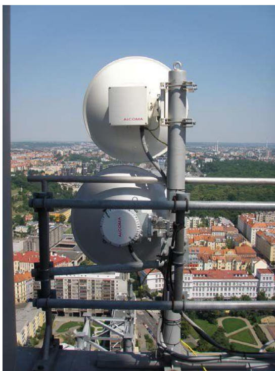
Obr. 1: „Vysílací antény experimentálního směrového spoje“ (převzato z [4])
