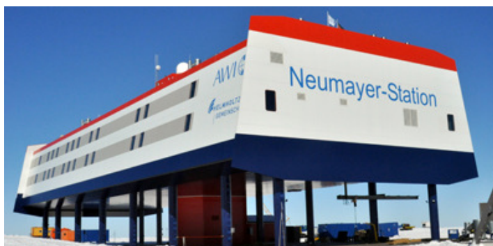
Obrázek 49. Nová německá výzkumná stanice Neumayer III v Antarktidě nahrazující výzkumnou stanicí Neumayer II je též zbudována na výškově stavitelných sloupech (Cieluch, 2010).
