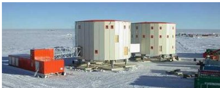
Obrázek 47. Francouzsko-italská základna Concordia postavena na fixovaných ocelových sloupech (ESA, 2006).
