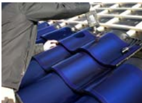
Obrázek 10. Montáž fotovoltaických panelů v podobě vlnité keramické střechy (Fischer, 2009).
