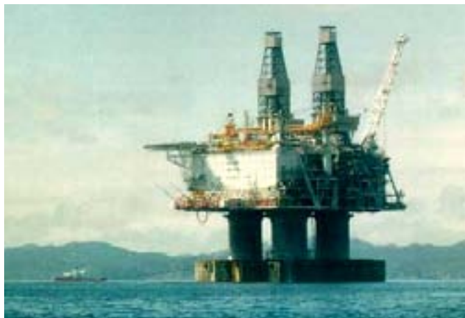
Obrázek 64. Těžební plošina Hybernia a zásobovací loď vlevo (foto z roku 1997). Základ plošiny tvoří hvězdicový caisson jež je pevně ukotven k mořskému dnu (Hibernia-Public-Affairs, 2000).
