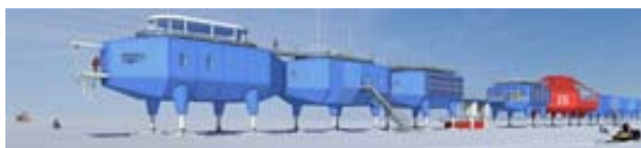
Obrázek 48. Britská stanice Haley IV – v současné době ve výstavbě. Základna je navržena jako soustava spojených modulů na stavitelných nohách s lyžemi (BAS, 2009).
