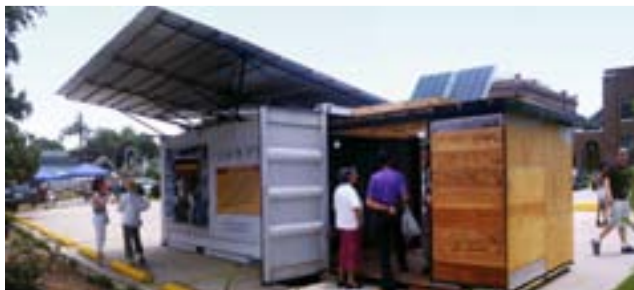
Obrázek 57. Kompletně samostatný habitat bez potřeby infrastruktury poskytuje vodu, hygienické zařízení a obnovitelný zdroj energie uvnitř standardního (intermodálního) kontejneru (Meinhold, 2010).
