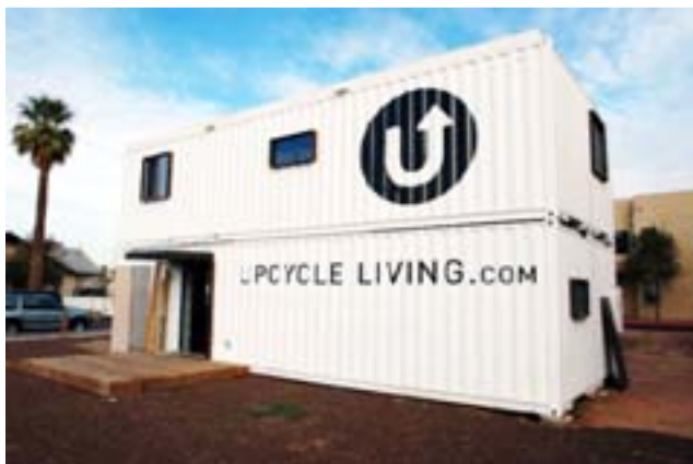
Obrázek 58. Plnohodnotné obydlí ve dvou či více intermodálních kontejnerech (Meinhold, Upcycle Living Rolls Out Affordable Shipping Container Housing, 2010).
