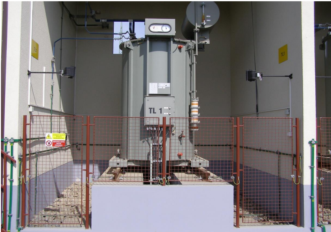
Obr. 4.7 – Zhášecí tlumivka
