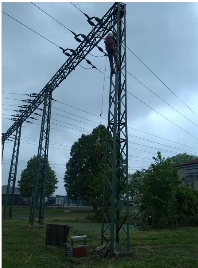
Obr. 4.15 – Instalace zemního vodiče na venkovní vedení
