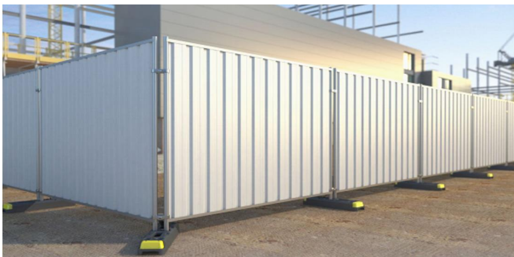
Obrázek 30: Mobilní oplocení staveniště [12]
