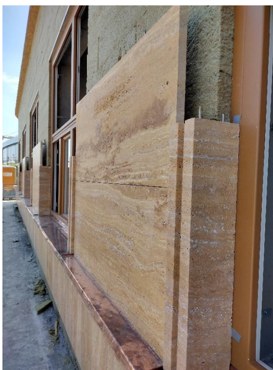
Obrázek 56: Pohled na travertinovou fasádu nástavby - palác Dunaj
