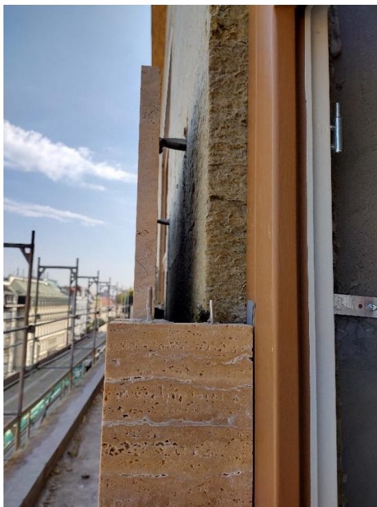
Obrázek 55: Detail na kotvení kamenných desek - palác Dunaj
