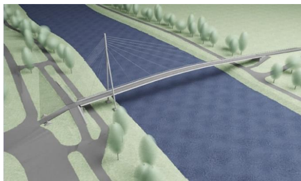
Obrázek 109: Lávka pro pěší a cyklisty z Polabce do ulice Na Vinici: var. zavěšená [6]
