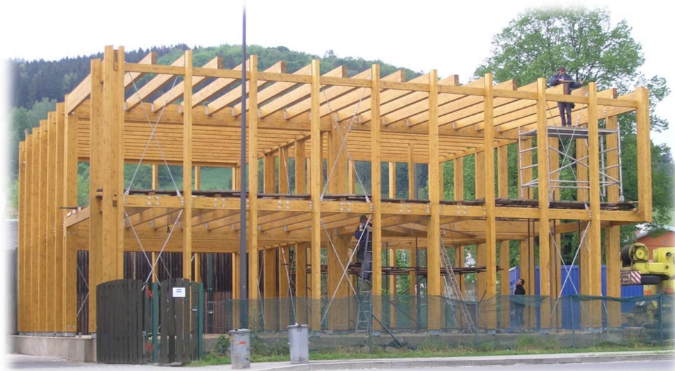
Obr. 9.1 Stavba konstrukce těžkého skeletu v Jeseníku
