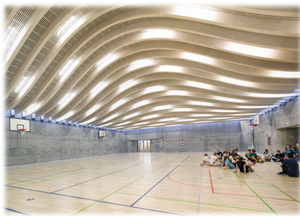
Obr. 9.5 Pohled na zakřivené nosníky z lepeného lamelového dřeva
