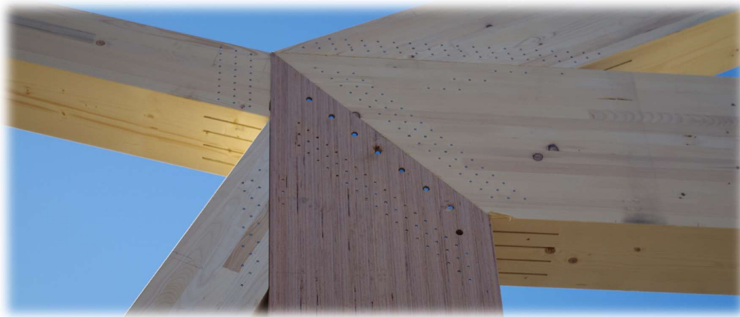
Obr. 6.5 Styčník spojený BSB systémem
