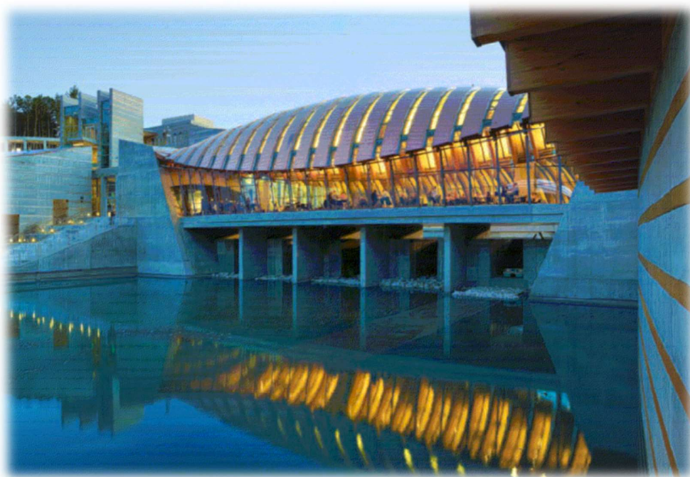
Obr. 9.8 Vnější pohled na budovu Crystal Bridges Museum of American Art
