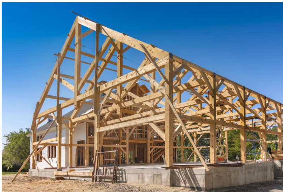
Obr. 35 – nosný skelet dřevostavby
