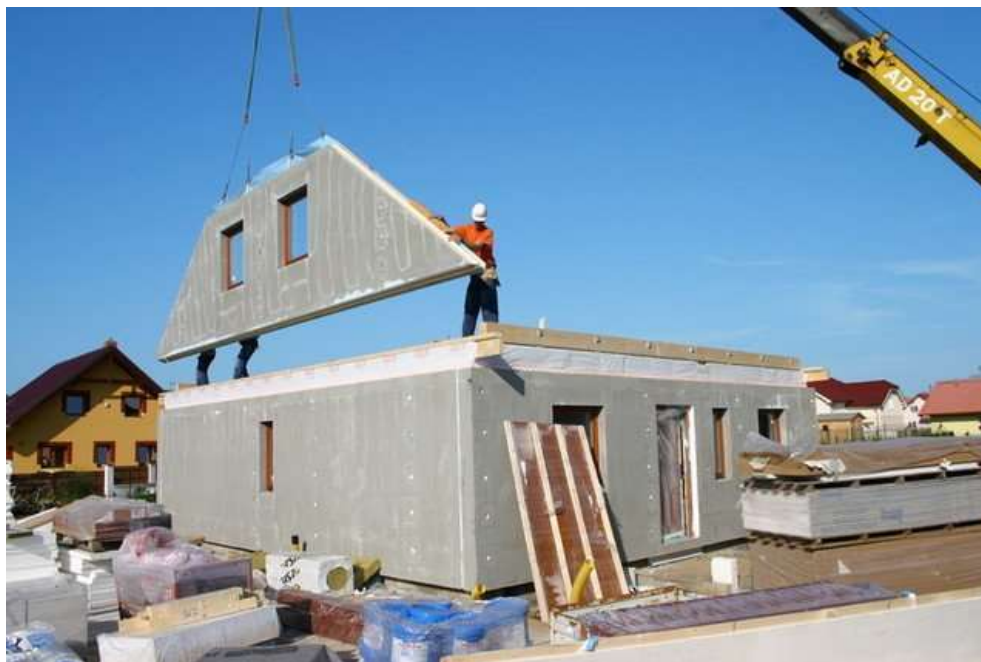
Obr. 32 – Montáž rámové dřevostavby
