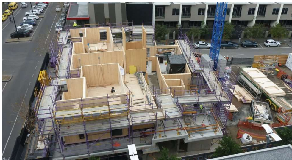
Obr. 39 – Výstavba budovy Forté
