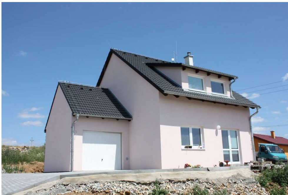
Obr. 33 – Rámová panelová dřevostavba RD Rýmařov
