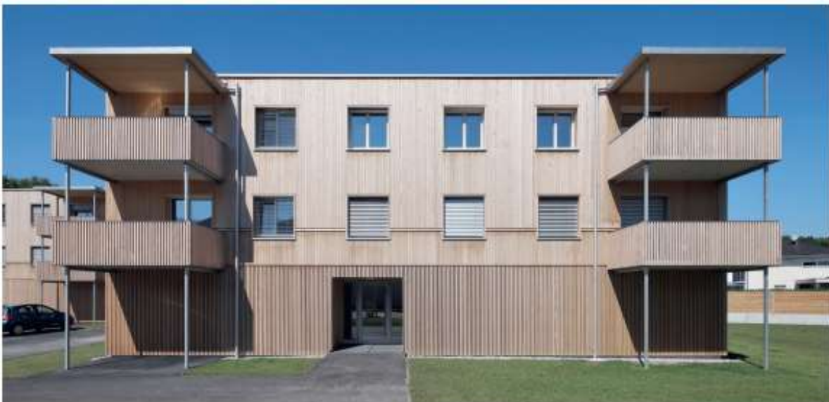
Obr. 22 - Příklad provedení předsazené konstrukce v modulární budově [32]
