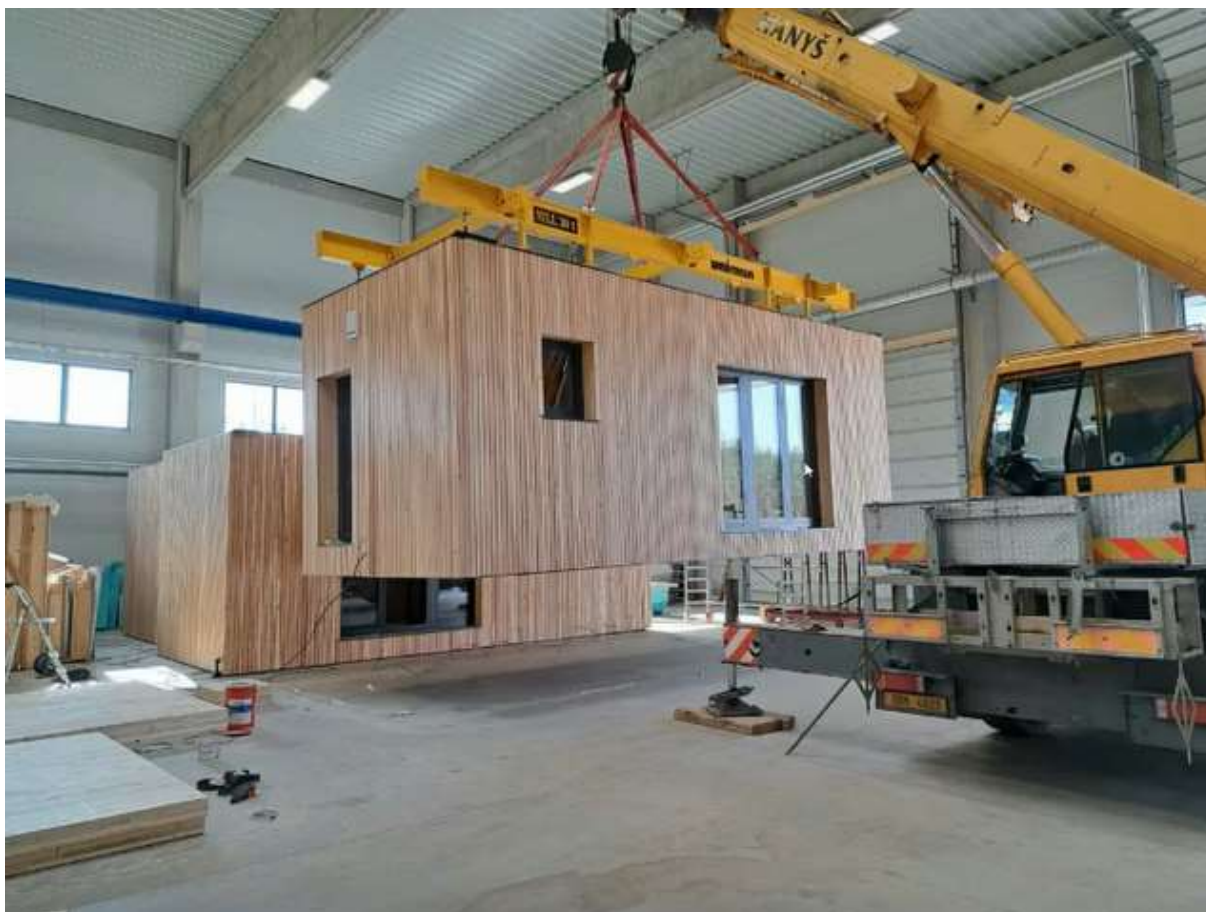
Obr. 31 - Zdvihání modulu za pomoci ocelového rámu [44]
