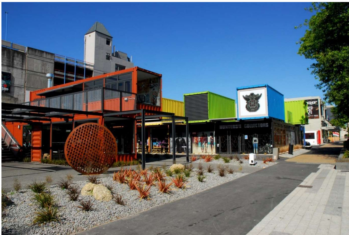
Obr. 3 - Dočasné kontejnerové obchodní centrum Re:START po zemětřesení ve městě Christchurch na Novém Zélandě [5]
