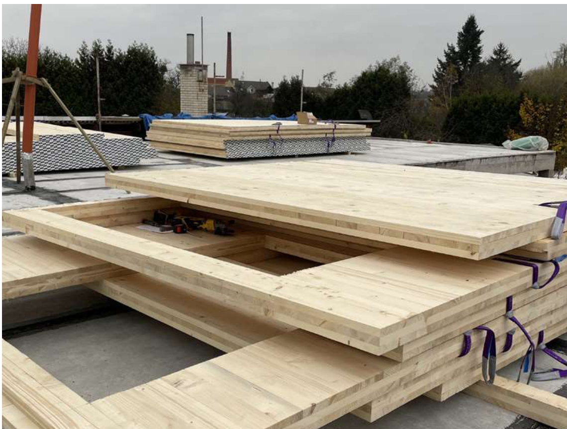
Obr. 14 - CLT panely připraveny na montáž [31]
