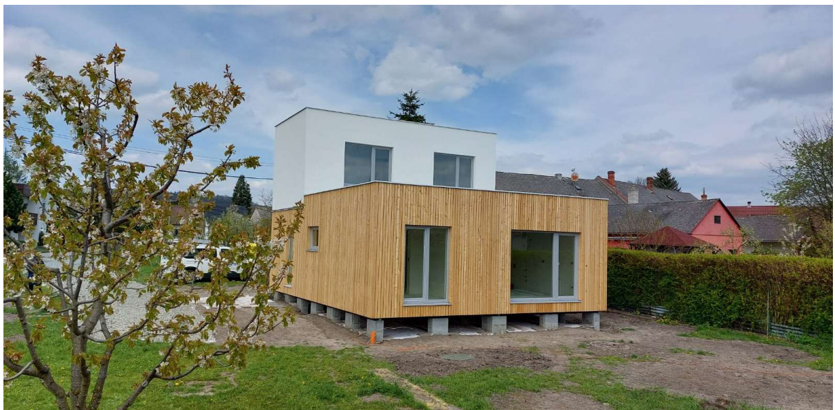
Obr. 36 – Realizace dvoupodlažního projektu firmy Eko Modular [51]
