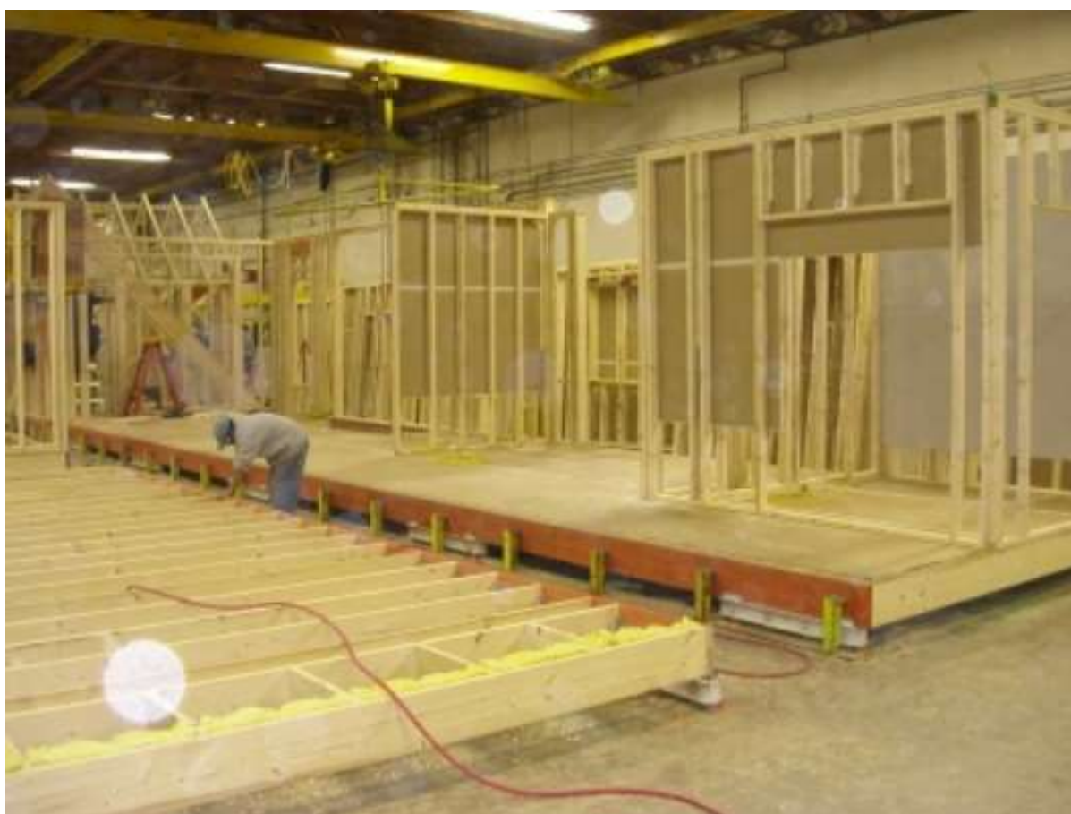
Obr. 19 - Rámová konstrukce modulu [36]
