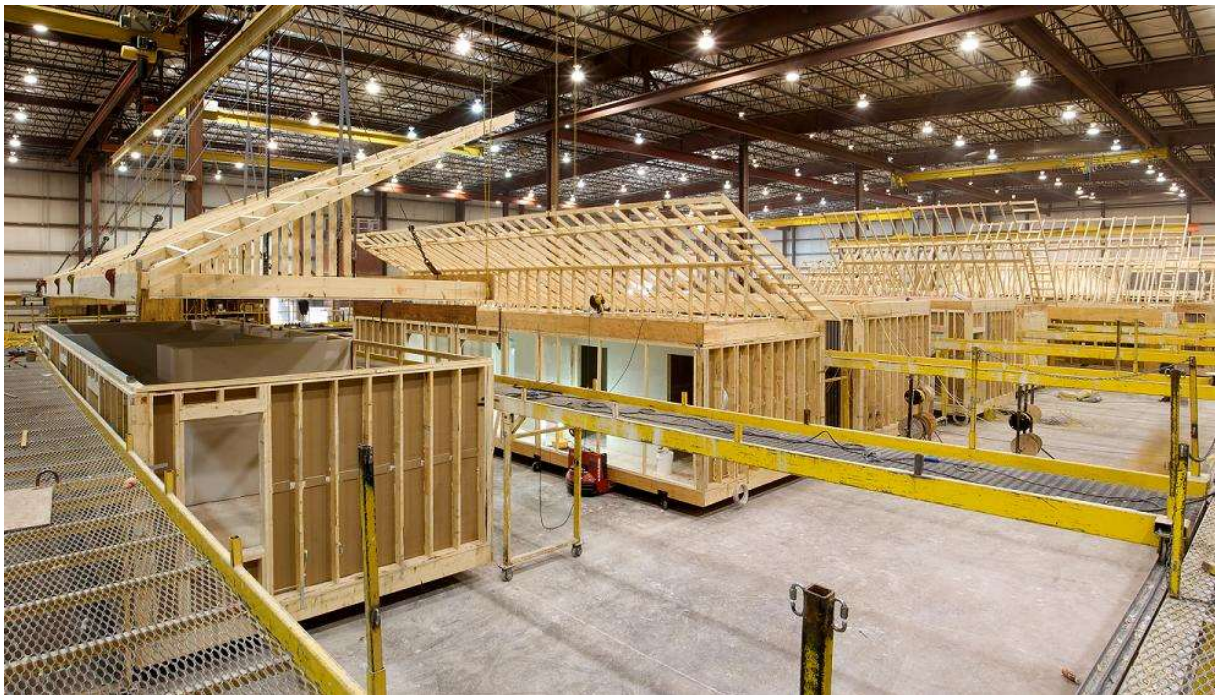
Obr. 23 - Moduly se střešní konstrukcí ve výrobní hale [68]
