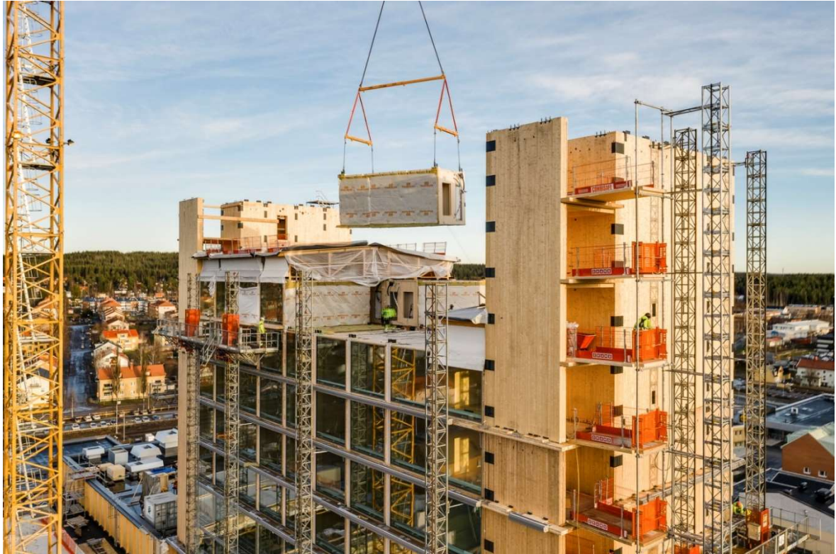
Obr. 46 - Výstavba projektu Sara Kulturhaus [67]
