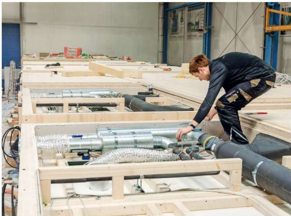
Obr. 21 - Instalace technických zařízení ve výrobní hale [32]
