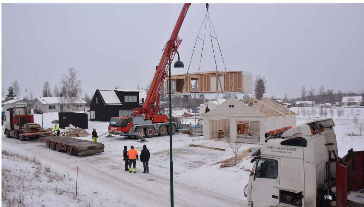
Obr. 32 - Montáž modulu pomocí mobilního jeřábu vybaveného upínacími popruhy [43]
