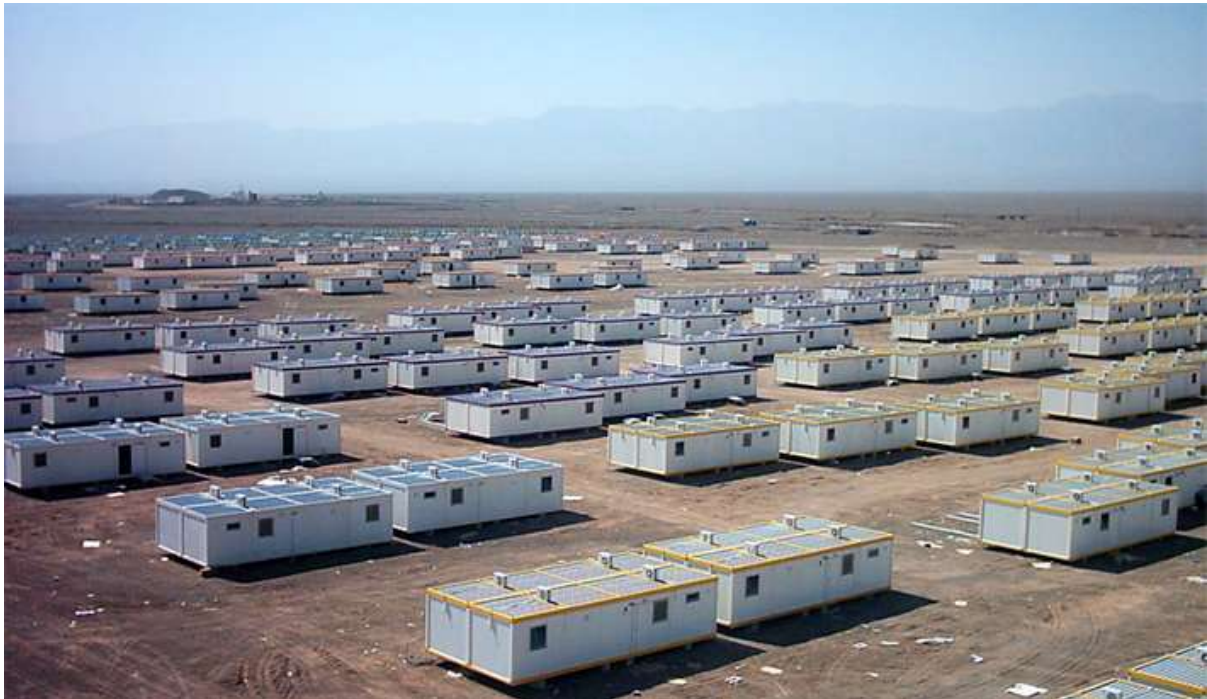
Obr. 4 - Nouzové ubytovací moduly pro lidi postižené zemětřesením ve městě Bam v Íránu [6]
