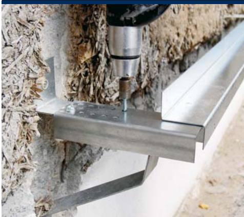
montáž s rektifikací U
