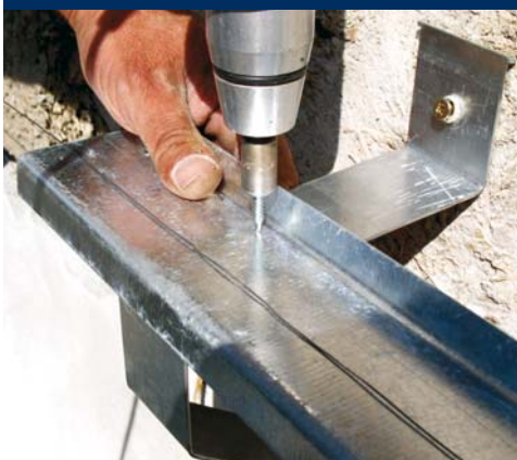
montáž bez rektifikace U
