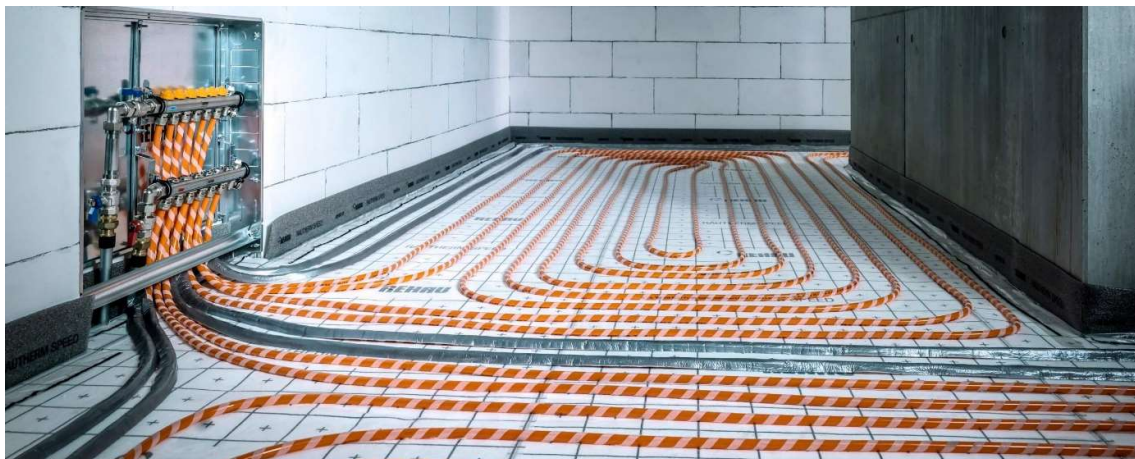
Obr. 13 Ilustrační fotografie podlahového vytápění mokrým systémem [19]
