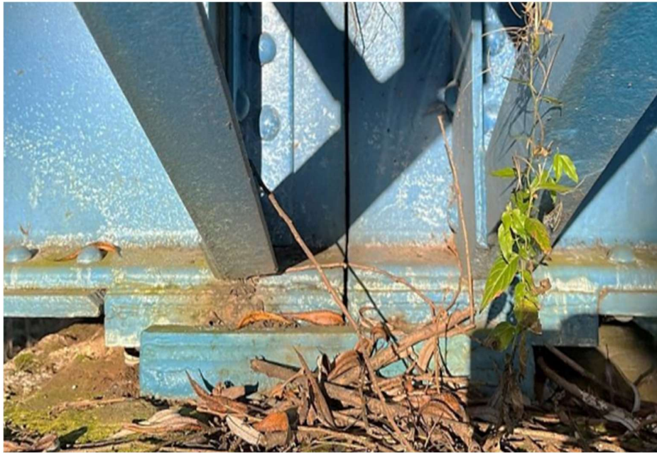
Obrázek 13: Sdružené ložisko K04/K05 [2]
