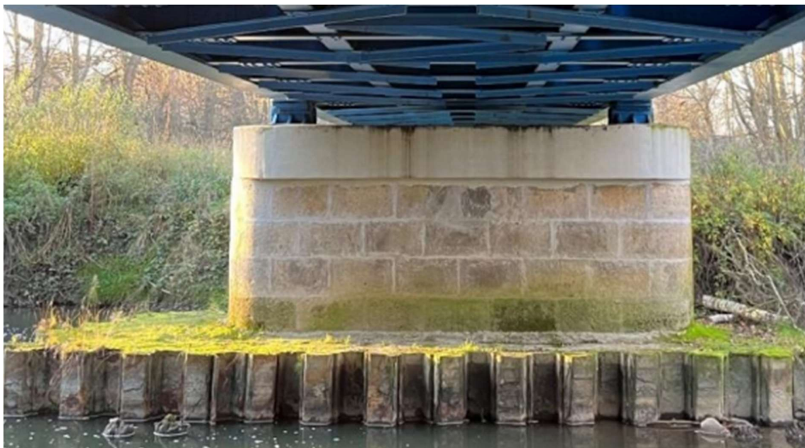
Obrázek 18: Dřík a ochrana pilíře P06 [2]
