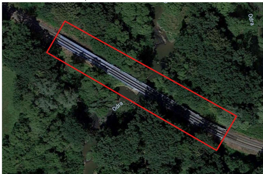
Obrázek 2: Satelitní snímek mostního objektu [4]
