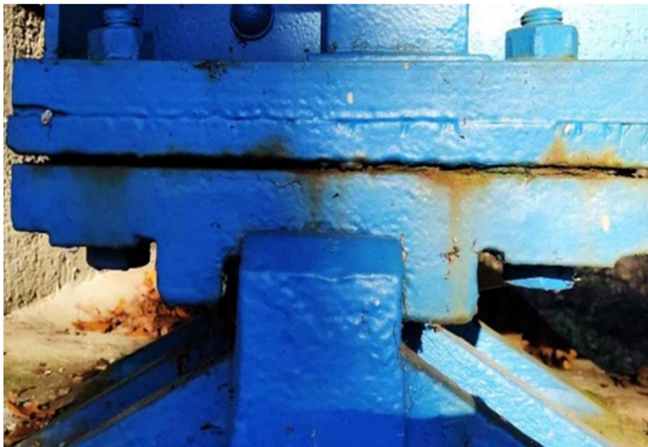
Obrázek 11: Pevné ložisko na opěře O01 [2]
