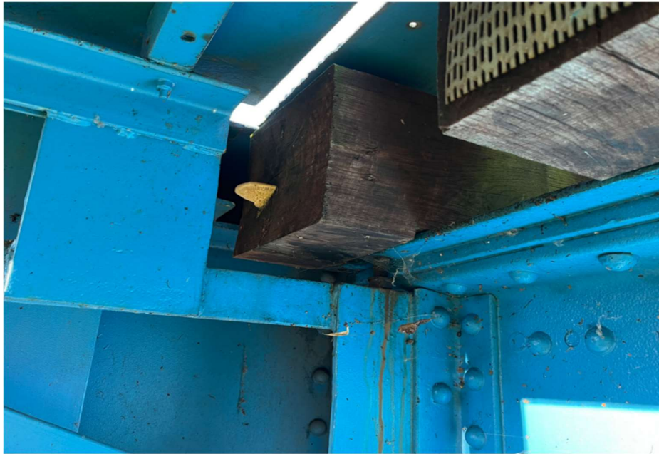
Obrázek 21: Mostnice napadená dřevokaznou houbou [2]
