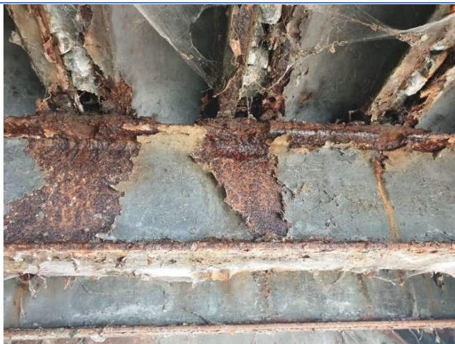
Obr. 16: Zkorodovaný podélník č. 8
