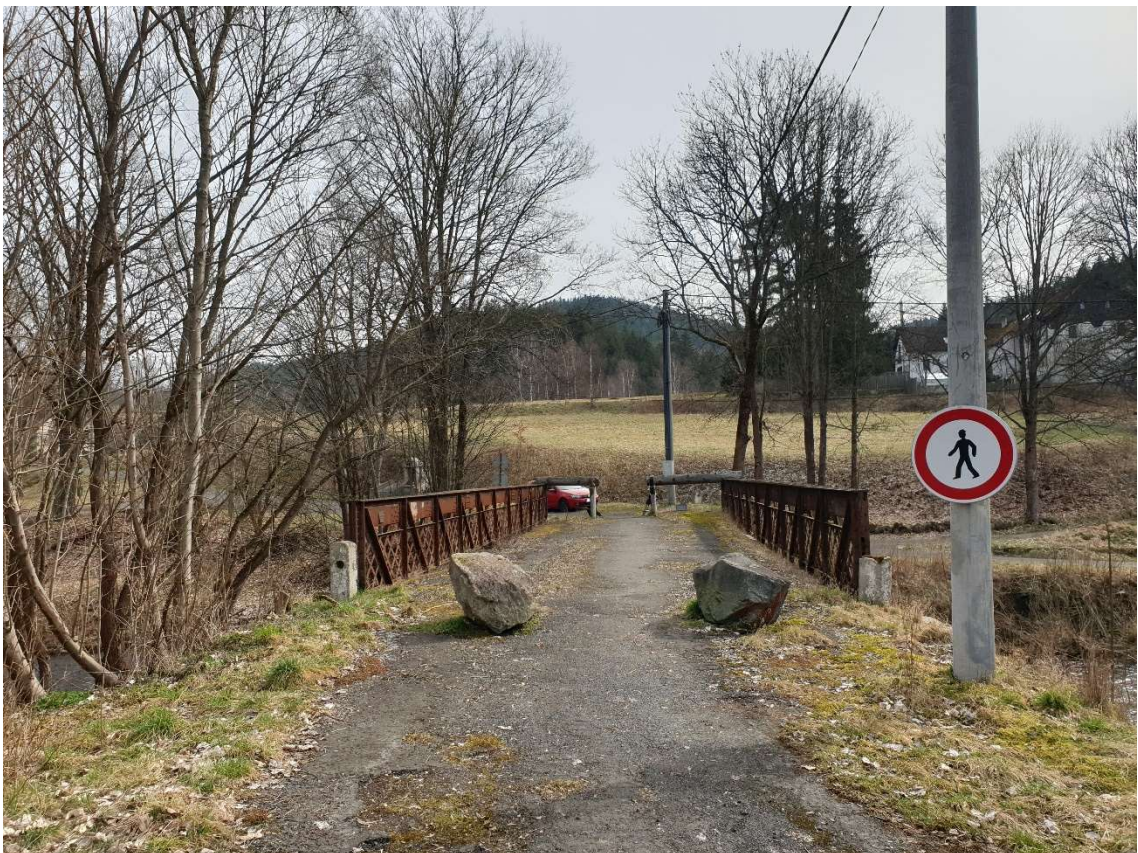
Obr. 2: Pohled na most od levého břehu
