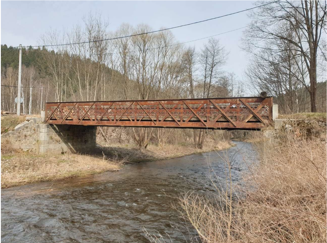
Obr. 1: Pohled na most ve směru toku
