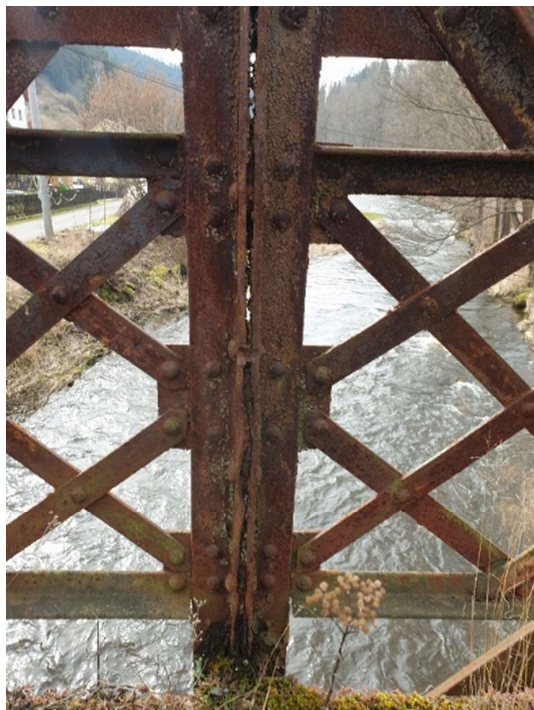
Obr. 11: Nárazem zdeformovaná svislíce č. 5 vlevo 2.4.2.2 Diagonály
