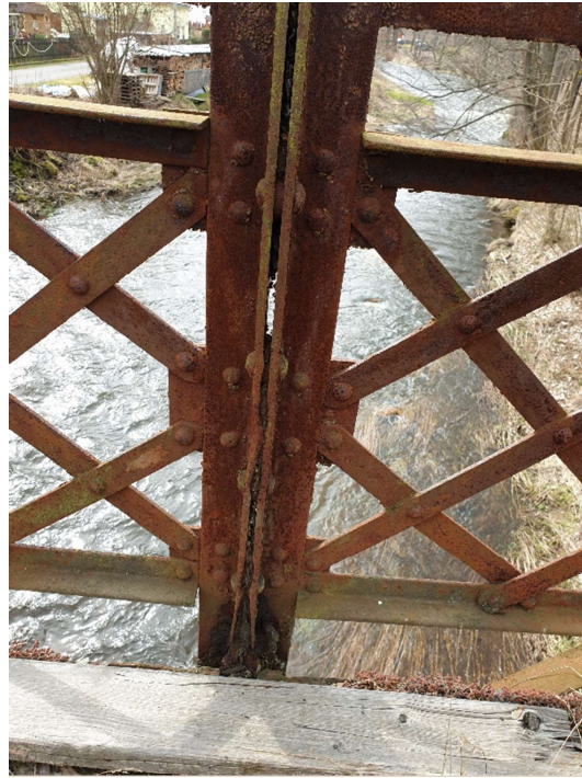
Obr. 12: Nárazem zdeformovaná svislíce č. 7 vlevo
