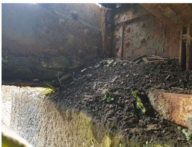
Obr. 8: Ložisko zanesené nečistotami
