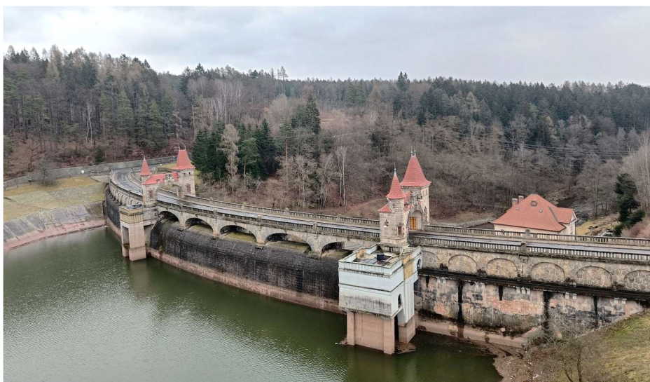
Obrázek 17 - Pohled ze šoupátkové věže na hráz přehrady a betonové přístavby (zdroj: autorka práce)
