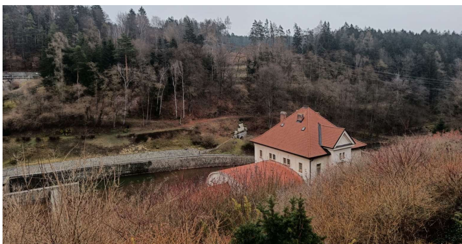
Obrázek 11 - Pohled z pravého břehu na vodní elektrárnu pod VD Les Království, v pozadí vyústění levého obtokového tunelu (zdroj: autorka práce)
