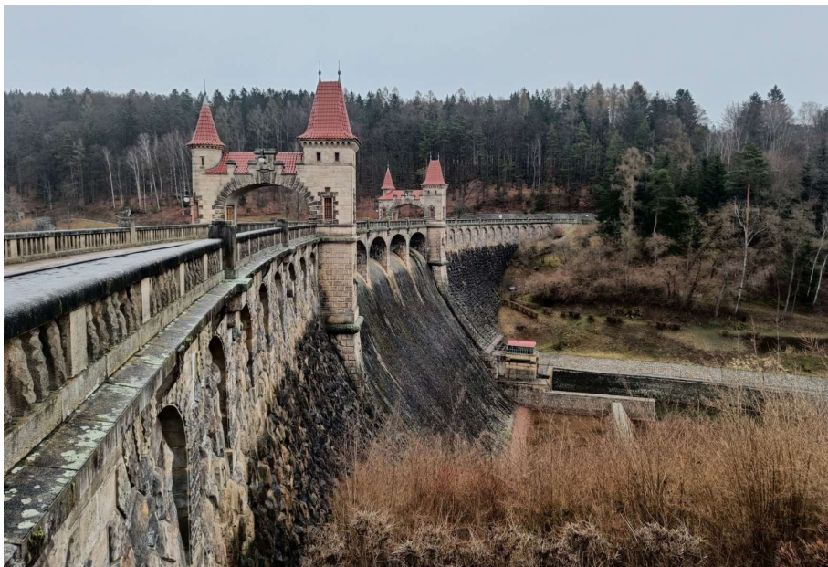
Obrázek 8 - Pohled na vzdušnou stranu hráze z pravého břehu (zdroj: autorka práce)
