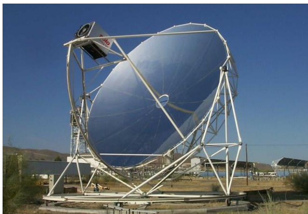
Obr. 17 Ukázka parabolického zrcadla se Stirlingovým motorem v ohnisku a mechanikou pro sledování slunce [17]
