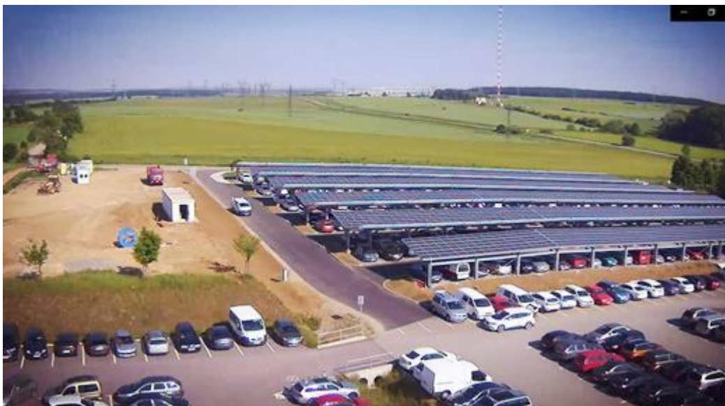
Obrázek 18- FVE na střeše parkoviště [23]
