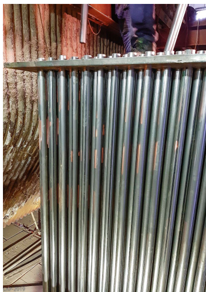
Obrázek 16: Nové LUVO dle návrhu pro uhelnou koncepci
