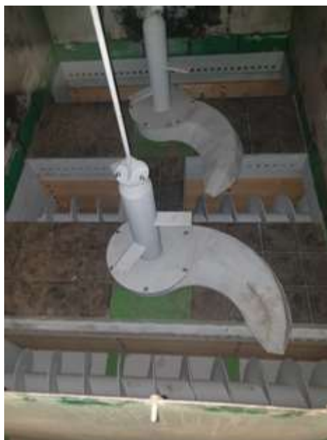
Obrázek 10: Vnitřek nového provozního zásobníku dřevní štěpky (rozdružovací hvězdice a pod nimi tři podávací šneky do pneumatického pohazovače do kotle)
