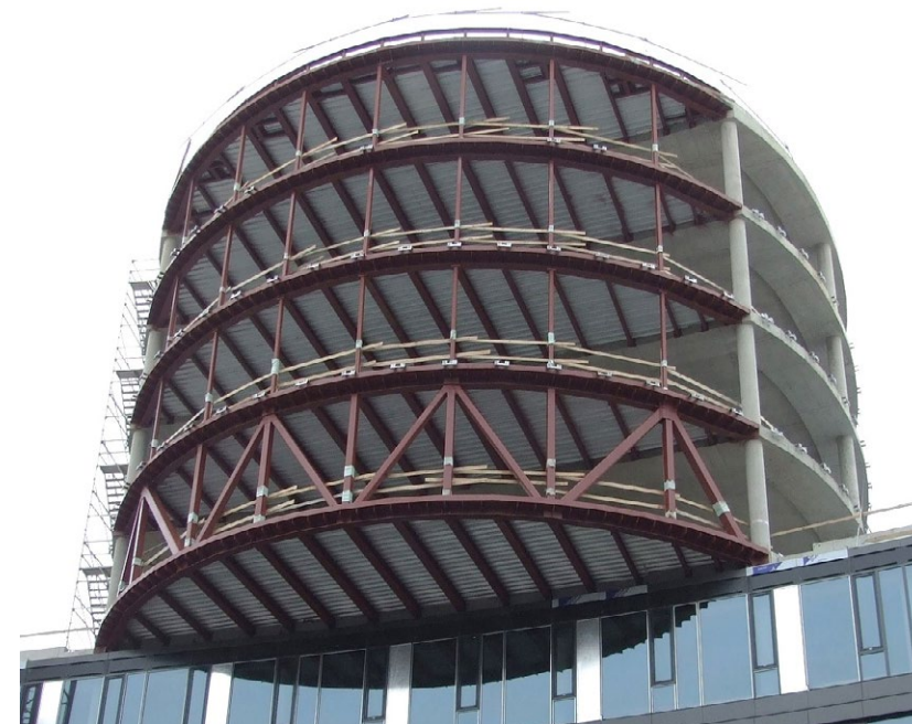
Inspirační konstrukční řešení. Projekt Aviatica. Zdroj: https://stavba.tzb-info.cz/izolace-strechy-fasady/13574-aviatica-brana-do-nove-ctvrty-byvale-waltrovky#fotogalerie
