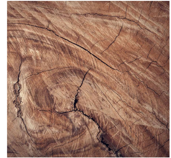
Krov Trámy dřevěného krovu
