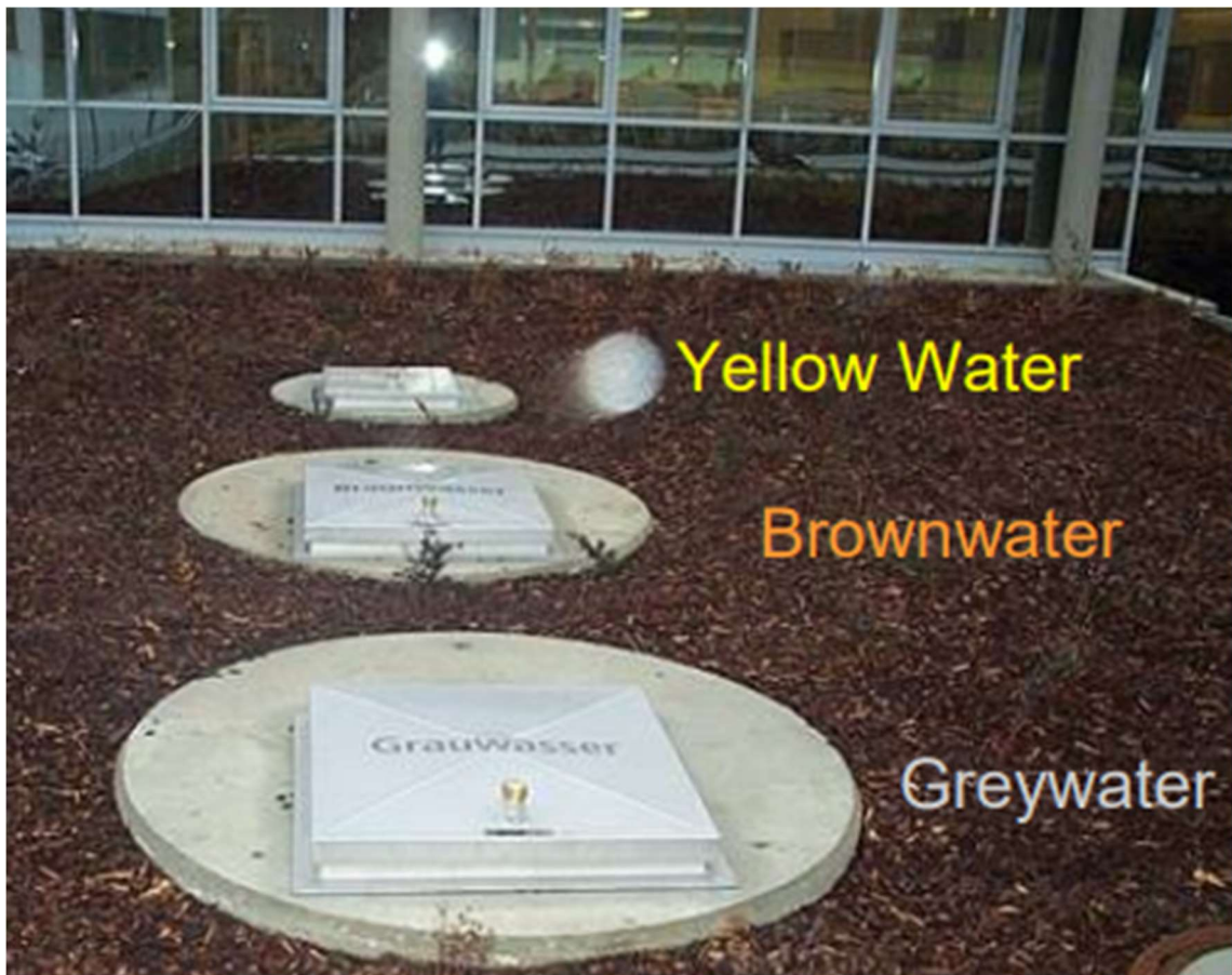
Obrázek 15: Vstupy do nádrží dle typu odpadní vody [36]
