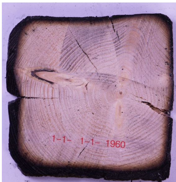
Obrázek 5-12 Zuhelnatění v místě trhliny
